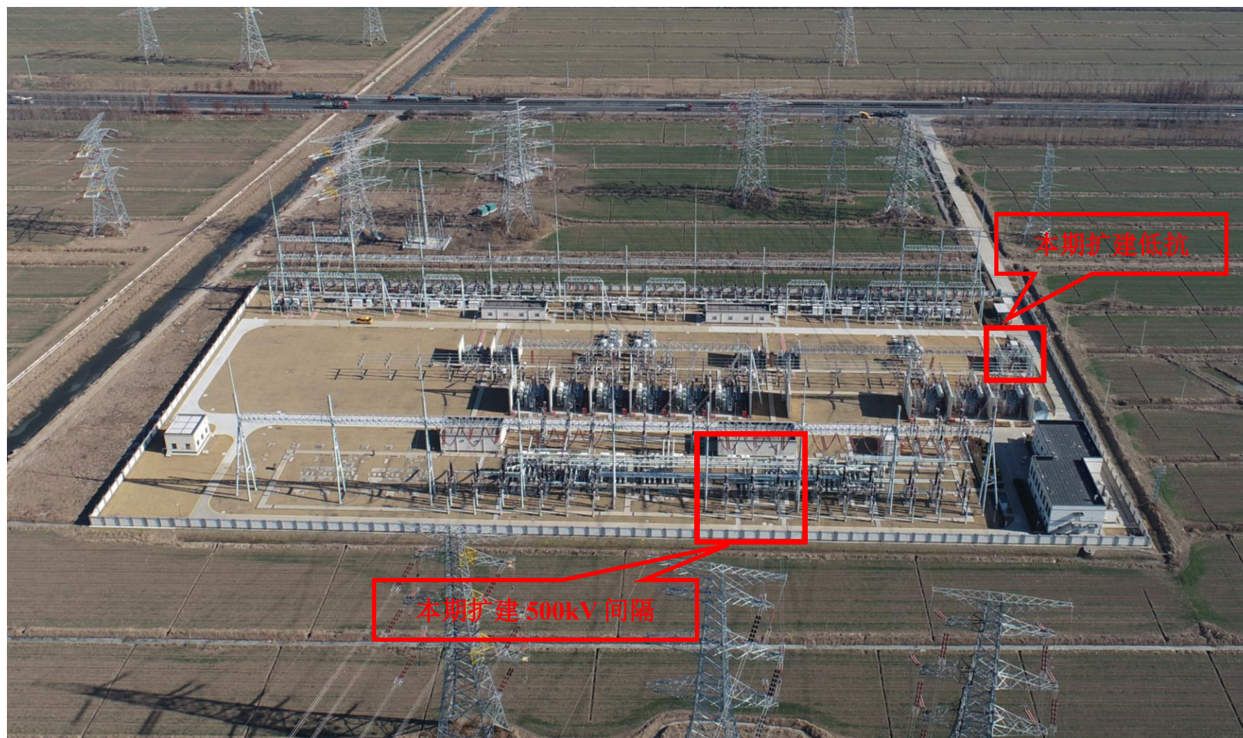
图 3-5 徐圩 500kV 变电站鸟瞰图
