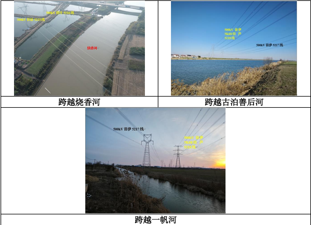
图 9-1 线路跨越河流照片
