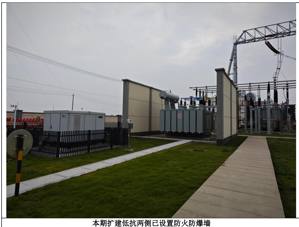
图 3-4 徐圩 500kV 变电站扩建工程环保设施及措施照片
