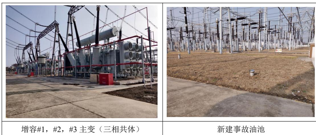
图 3.3-4 吴江 500kV 变电站本期新建设施
