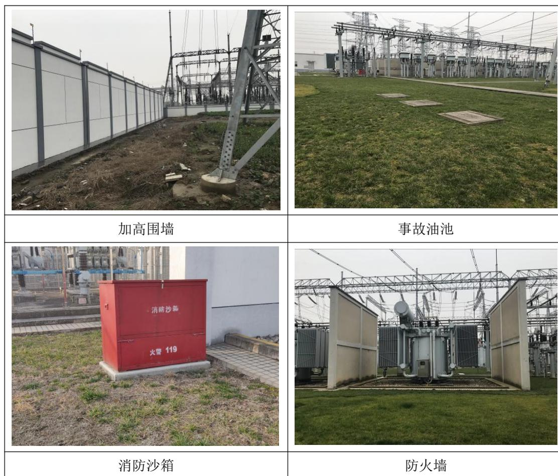
图 3.3-2 吴江 500kV 变电站前期工程的环保设施
