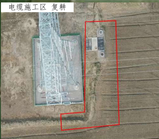
电缆施工区 复耕
