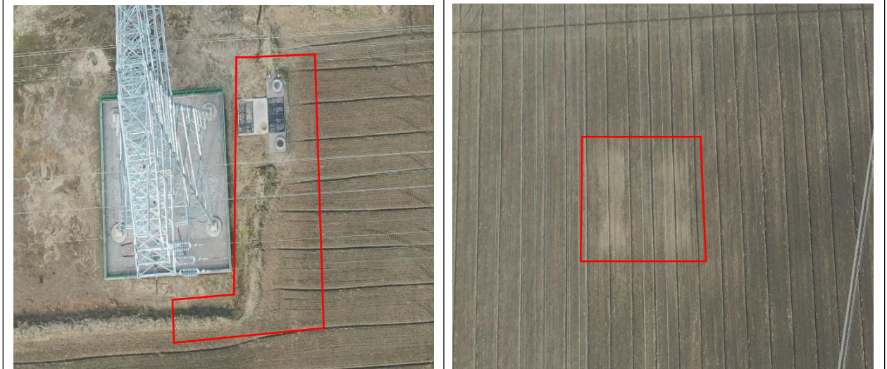
电缆施工区 复耕 (2024.1)
