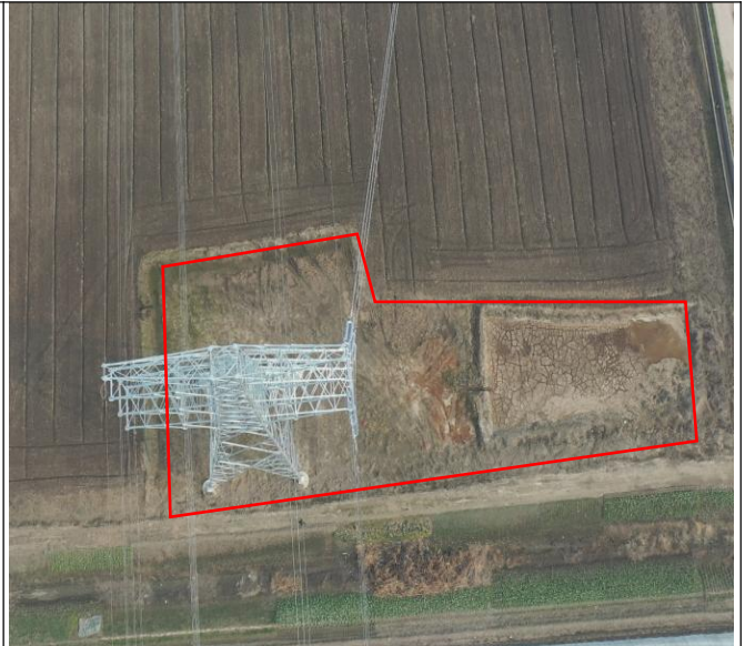
2024 年 1 月 施工后塔基区
