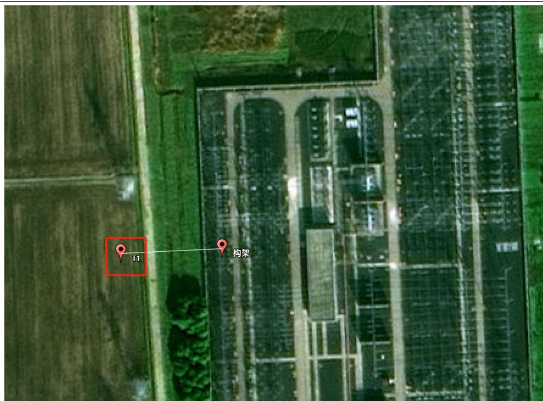
T1 塔（开工前）
