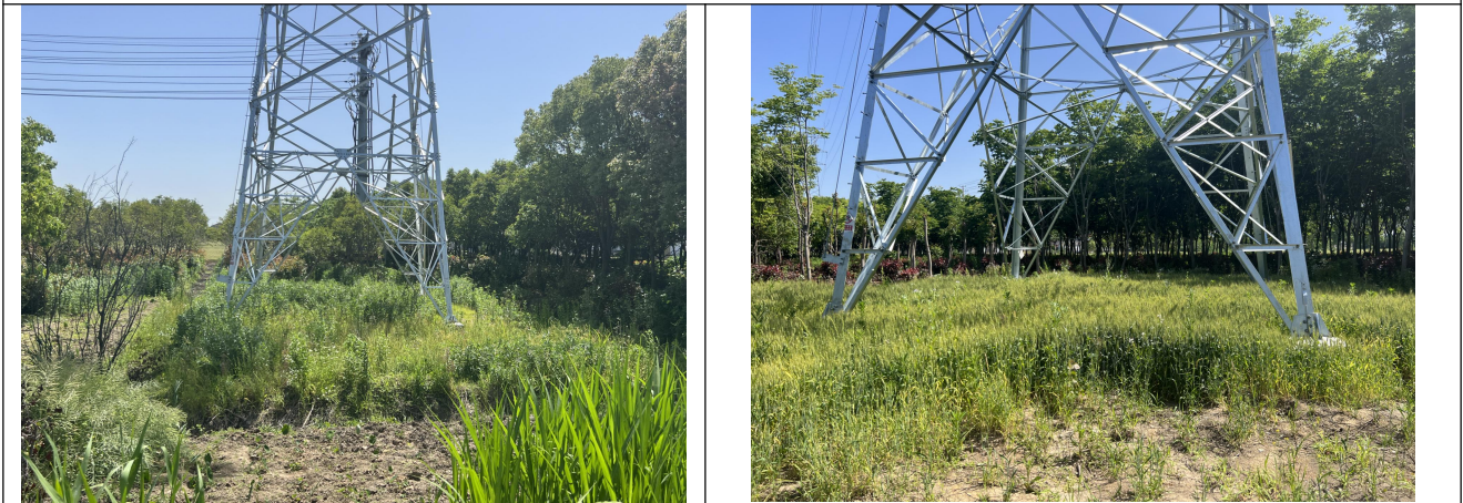
塔基生态恢复
