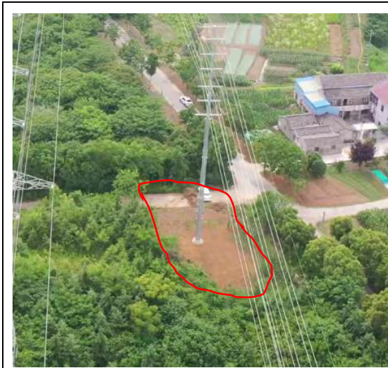
塔基区 T7 复耕（2024 年 6 月）
