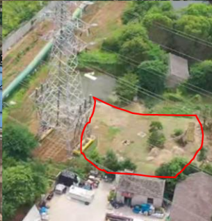
电缆施工区撒播草籽（2024年6月）
