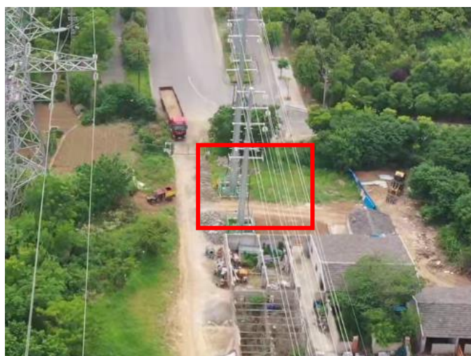
塔基区完工后 2024.06
