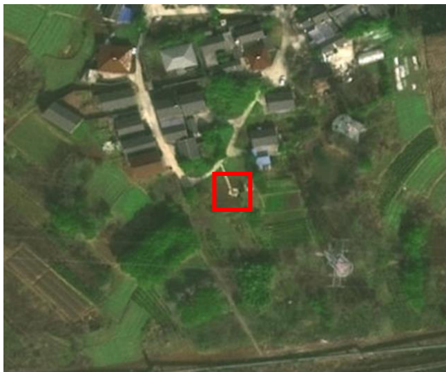
塔基区施工过程中 2023.04
