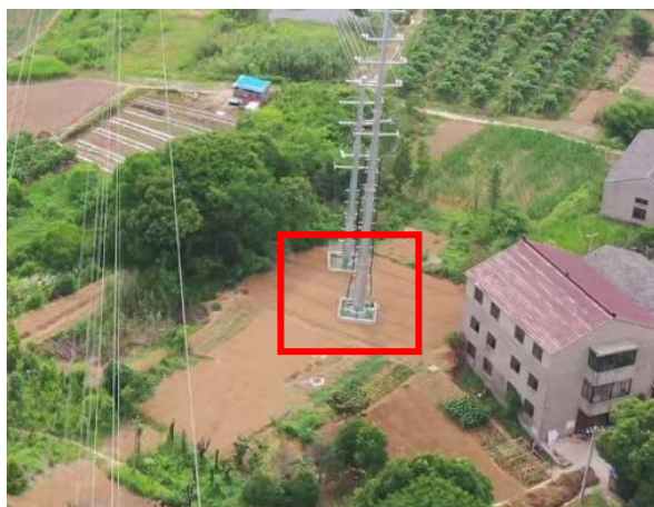
塔基区完工后 2024.06
