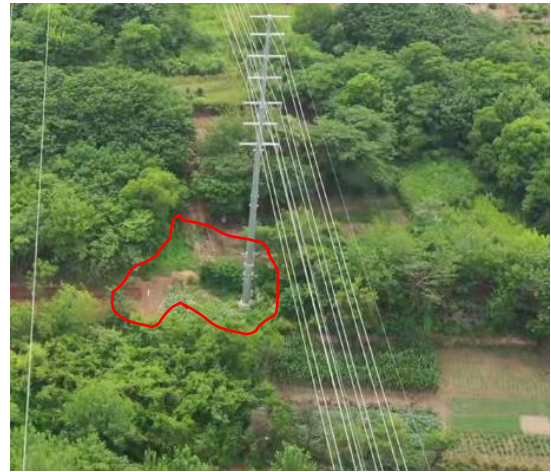
塔基区 T8 撒播草籽（2024 年 6 月）
