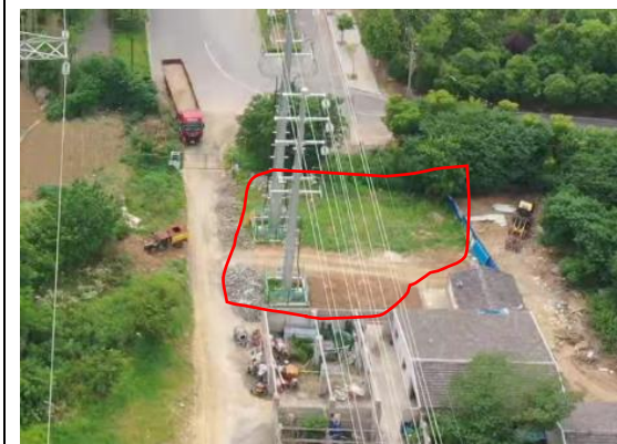
塔基区 T9、T10 复耕、撒播草籽（2024 年 6 月）
