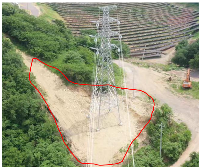
塔基区完工后 2024.06
