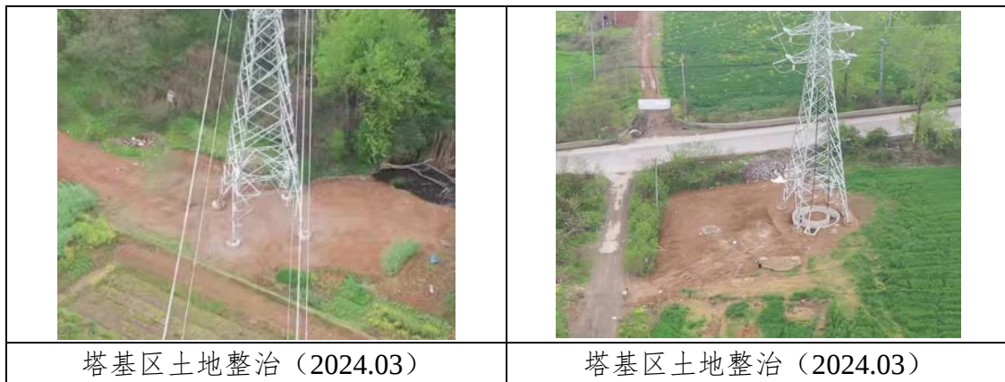
图 4-1 水土保持工程措施实施情况
