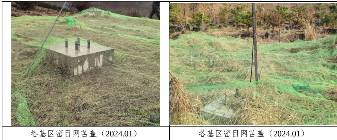
图 4-3 水土保持临时措施实施情况
