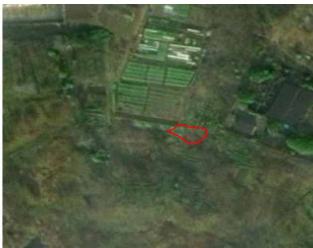
塔基区施工前期 2023.03
