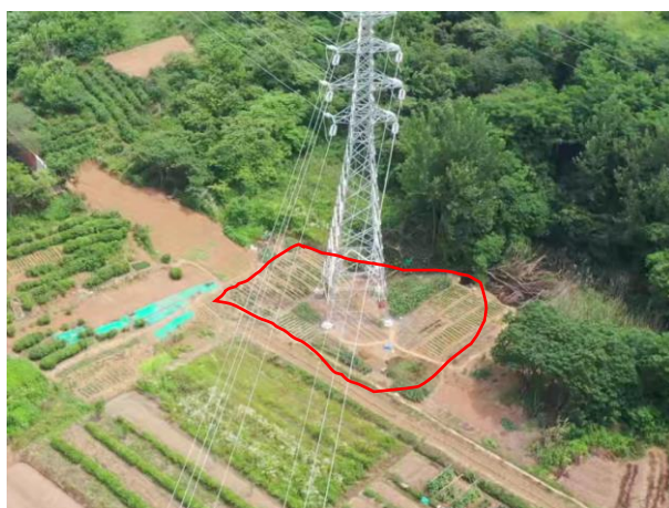
塔基区完工后 2024.06
