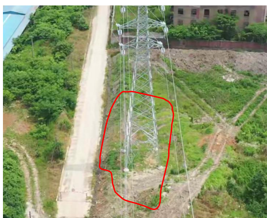
塔基区完工后 2024.06
