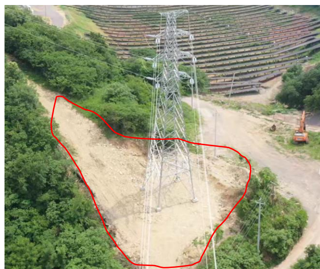
塔基区完工后 2024.06
