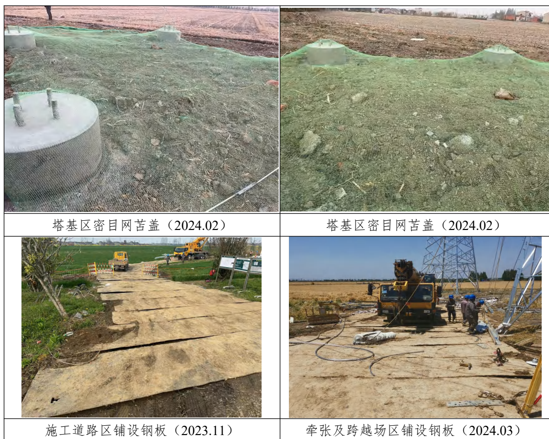
图 4-3 水土保持临时措施实施情况
