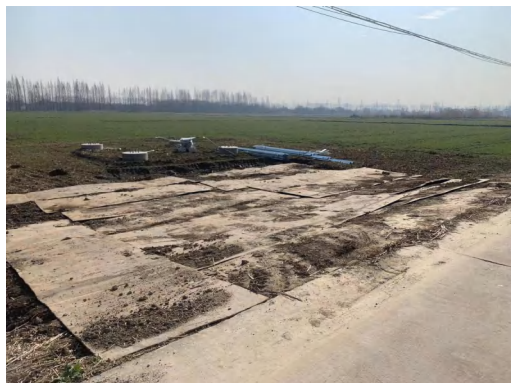
施工道路区铺设钢板（2024 年 2 月 21 日）
