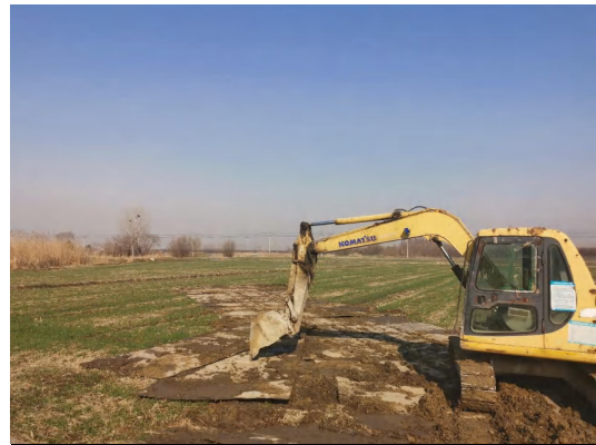
施工道路区铺设钢板（2024 年 2 月 21 日）
