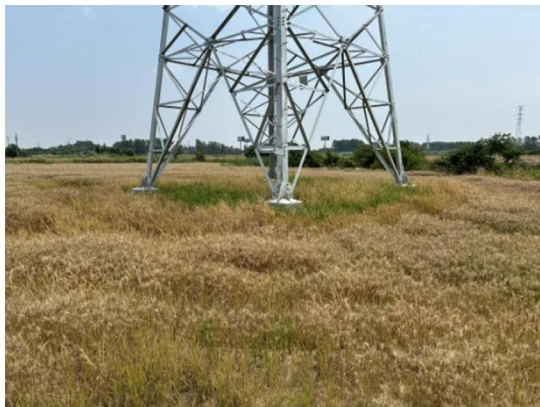
塔基区复耕恢复
