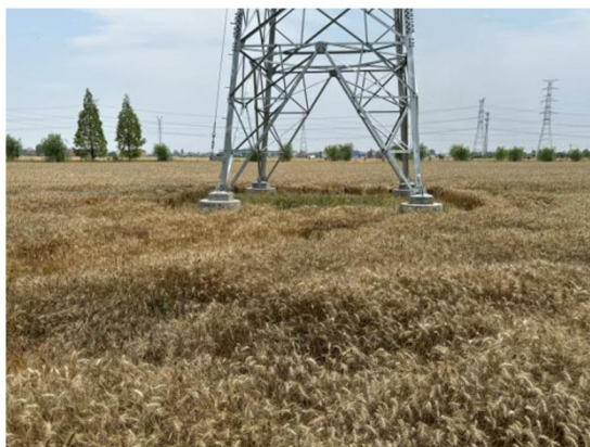
塔基区复耕恢复
