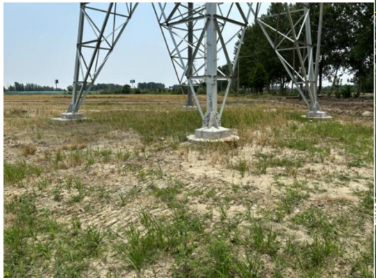
塔基区撒播草籽恢复
