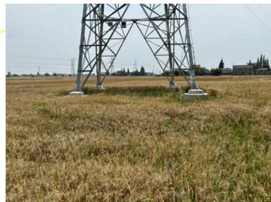
塔基区复耕恢复
