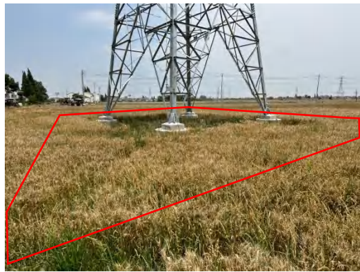
塔基区 T12 复耕 (2024 年 6 月)
