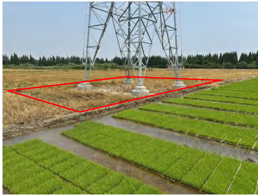
塔基区 T9 复耕 (2024 年 6 月)
