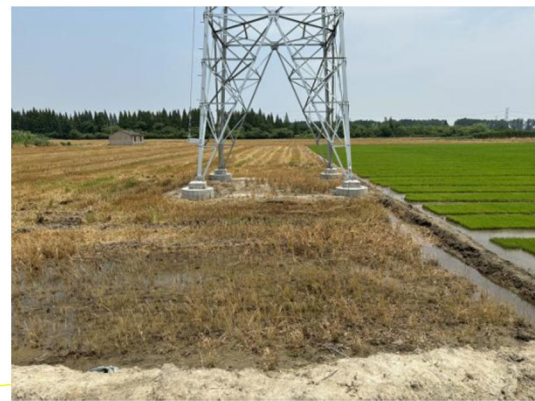
塔基区复耕恢复
