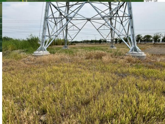
塔基区复耕恢复
