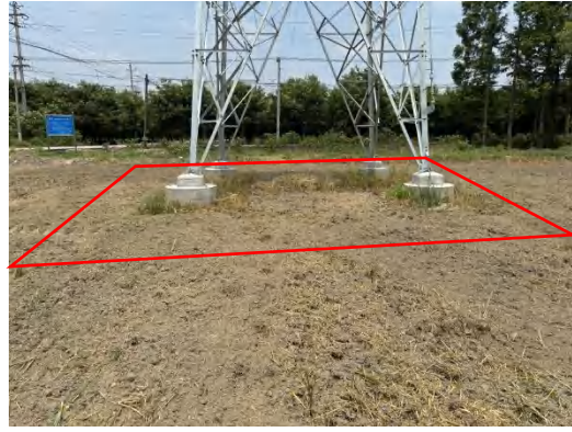
塔基区 T8 复耕 (2024 年 6 月)
