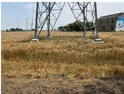
塔基区 T13 复耕 (2024 年 6 月)
