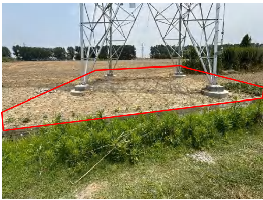
塔基区 T11 复耕 (2024 年 6 月)
