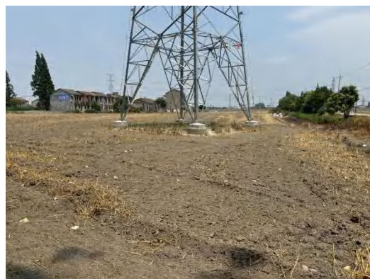
塔基区 T14 复耕 (2024 年 6 月)
