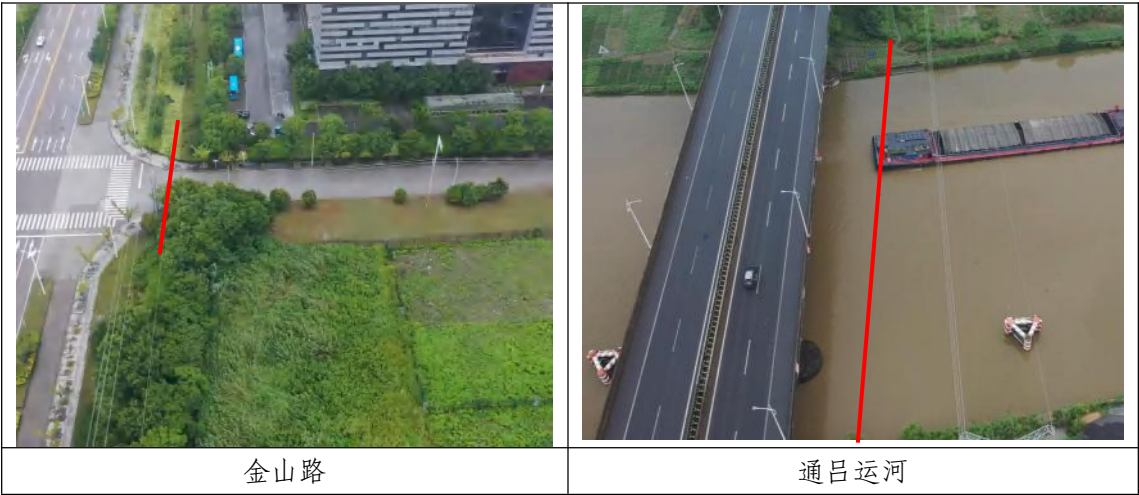
图 1.1-7 跨越处现场照片
