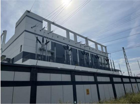
变电站内 110kV GIS 配电装置楼
