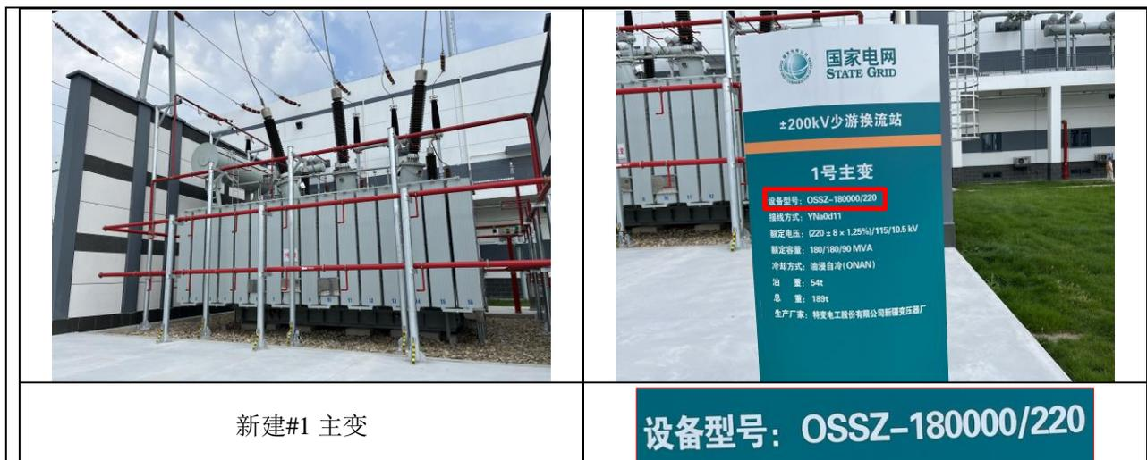
图 4-1 本工程变电站内主变及主变铭牌照片
