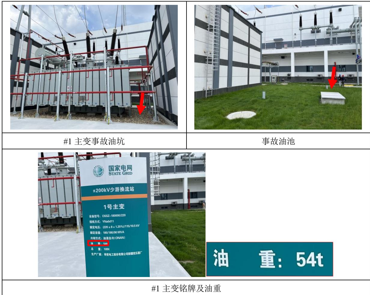
图 8-4 本工程变电站事故油池、事故油坑及主变铭牌照片
