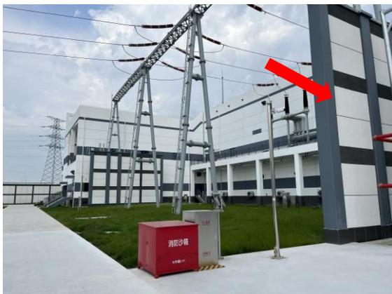
变电站内主变之间防火隔声墙及消防设施
