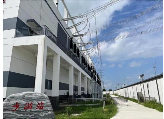
变电站内 220kV GIS 配电装置楼
