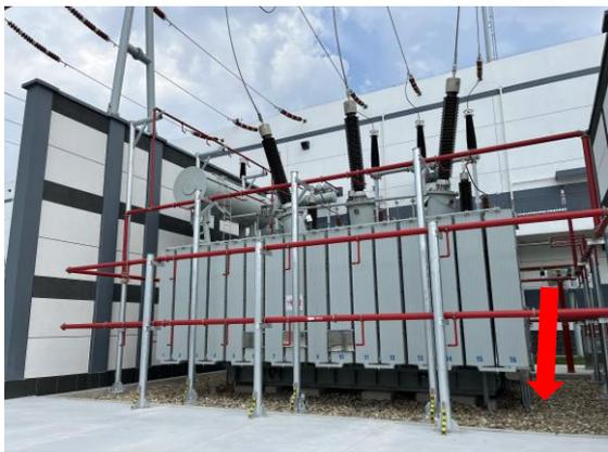
变电站内主变下方事故油坑
