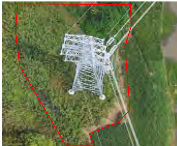
N10、施工道路 复耕 (2024.10)
