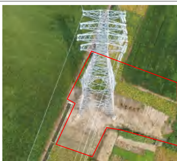
N8、施工道路 复耕 (2024.10)
