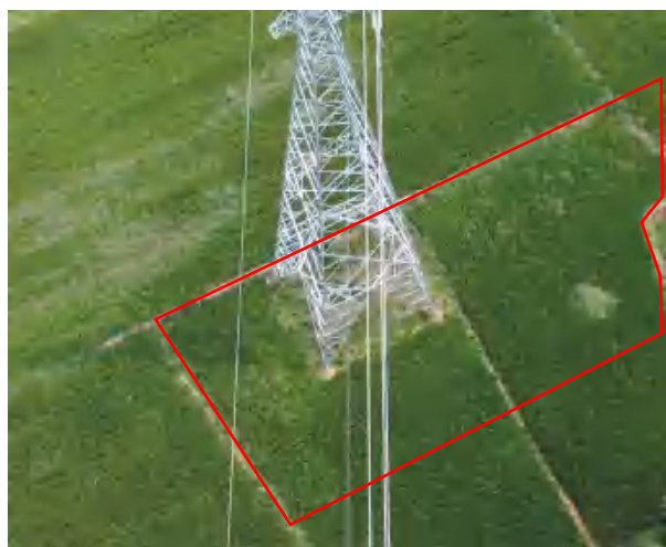
N9、施工道路 复耕 (2024.10)
