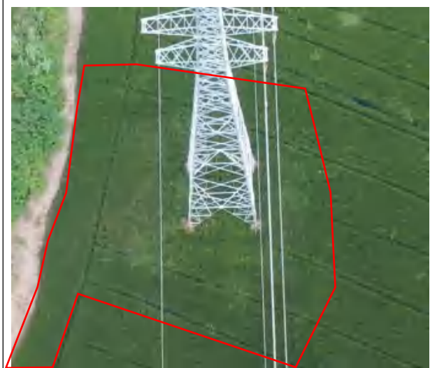
N11、施工道路 复耕 (2024.10)
