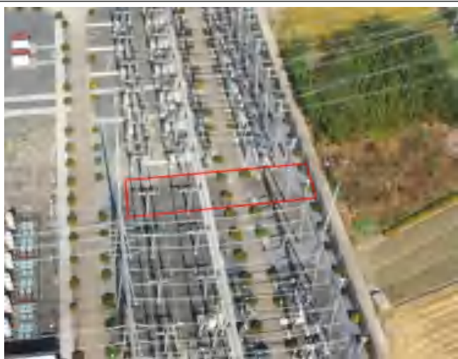
2023 年 10 月 间隔扩建区施工前
