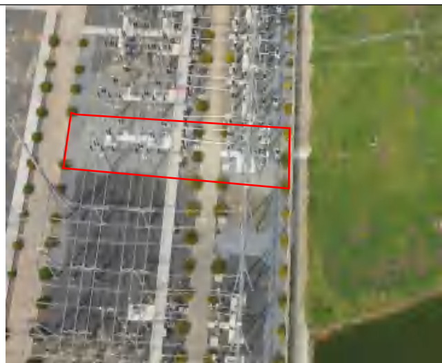
2024 年 10 月 间隔扩建区施工后
