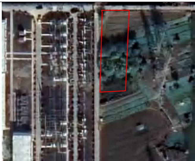
2023 年 10 月 电缆施工区施工前
