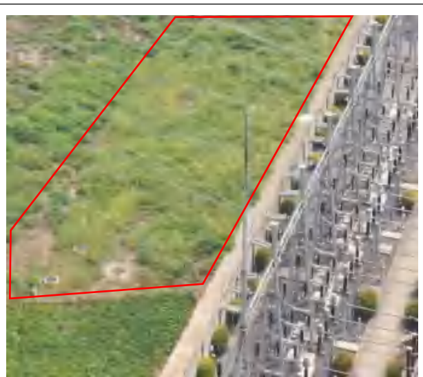
电缆施工区 撒播草籽（2024.10）
