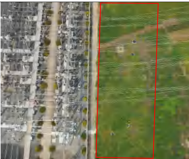
2024 年 10 月 电缆施工区施工后
