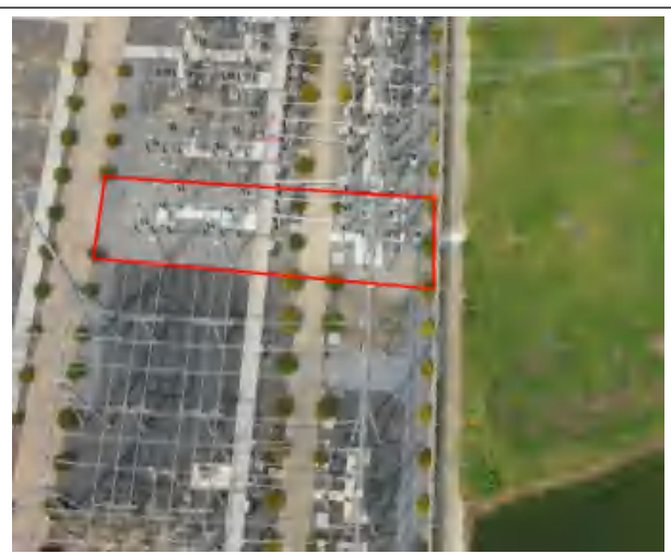
间隔扩建区 碎石地坪（2024.10）
