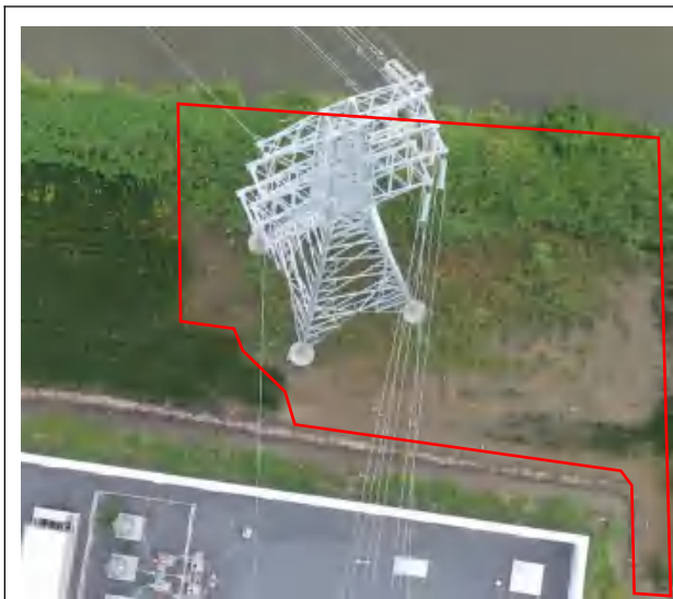
N13、施工道路 复耕（2024.10）
