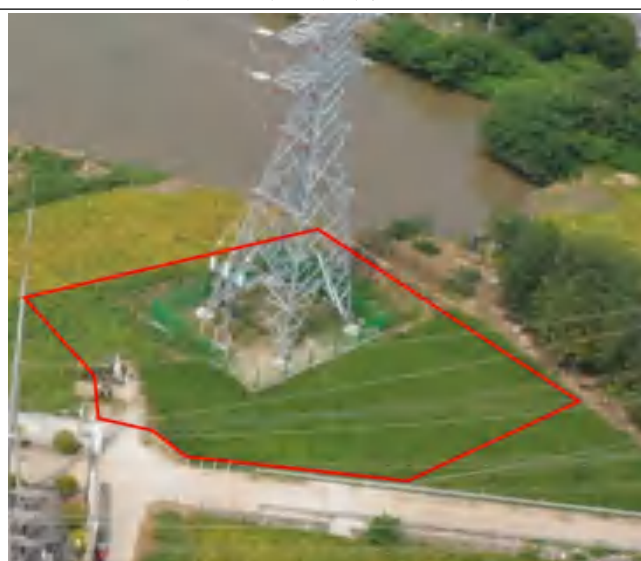
2024 年 10 月 塔基区施工后
