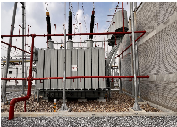
黄滕 220kV 变电站#2 主变压器事故油坑
