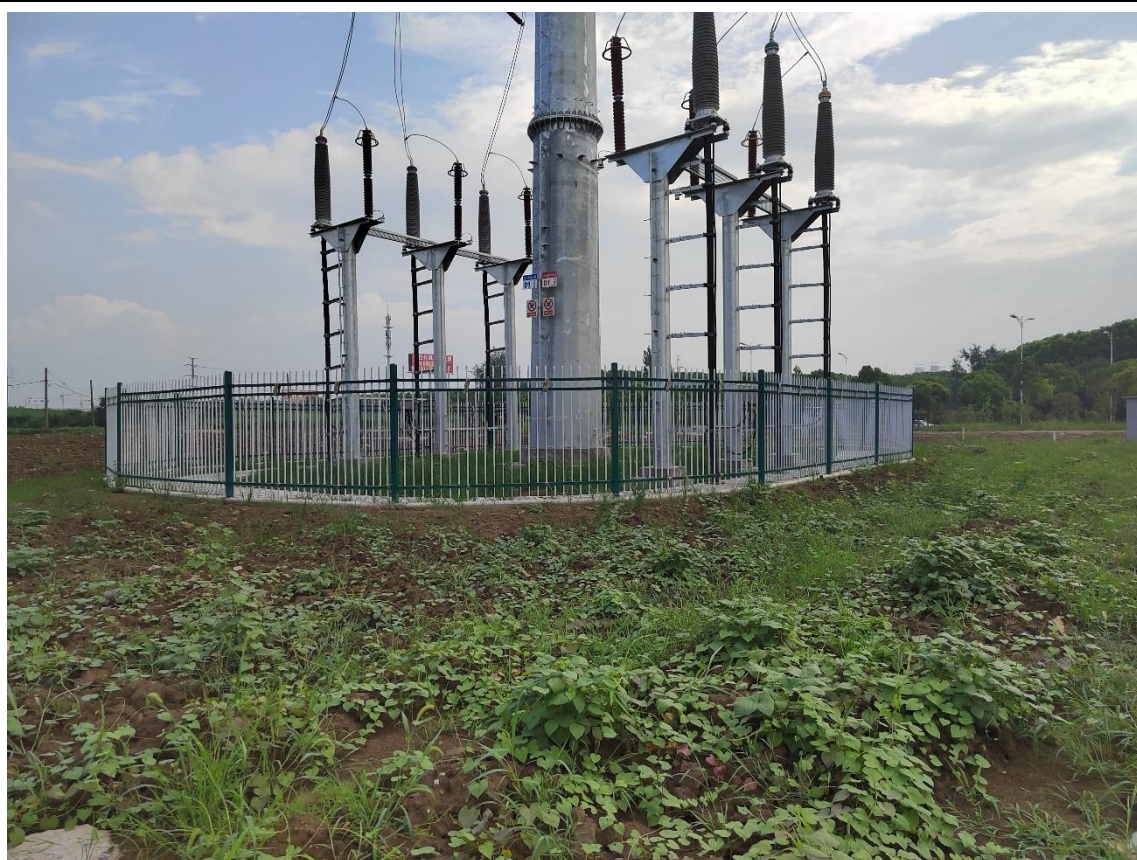
塔基区建设后影像（2024 年 8 月）
