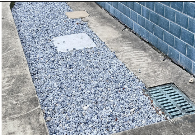
森园 110kV 变电站站内硬化道路、碎石铺盖
