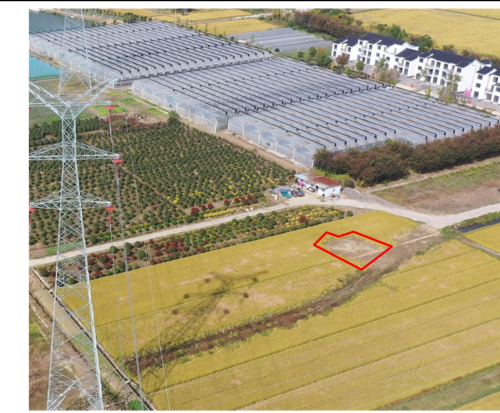
拆除区（百美线78#塔） 复耕 2024.11
