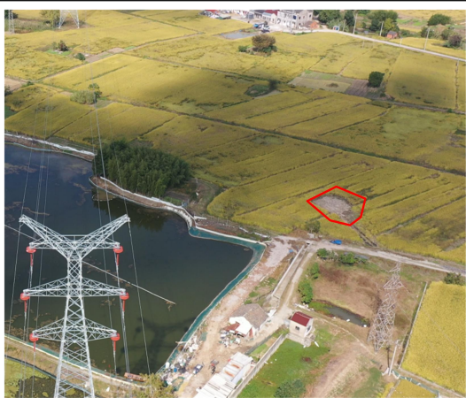
拆除区（百美线74#塔） 复耕 2024.11
