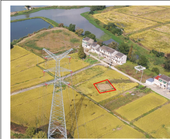
拆除区（百美线73#塔） 复耕 2024.11
