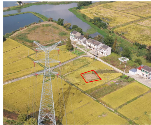
拆除区 (百美线73#塔) 施工后 (2024.11)
