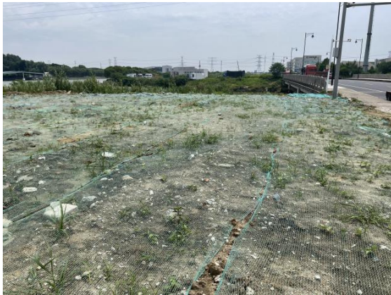
电缆施工区防尘网苫盖 (2024.5)
