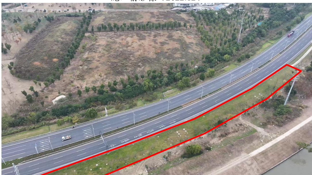
电缆施工区施工后影像（2024.12）
