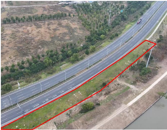
电缆施工区撒播草籽（2024.12）
