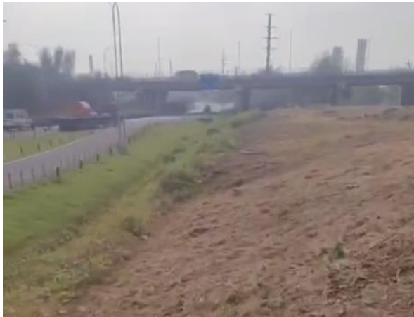
电缆施工区撒播草籽（2024.12）
