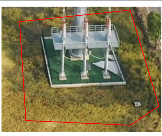
塔基区 T2 复耕 (2024.11)
