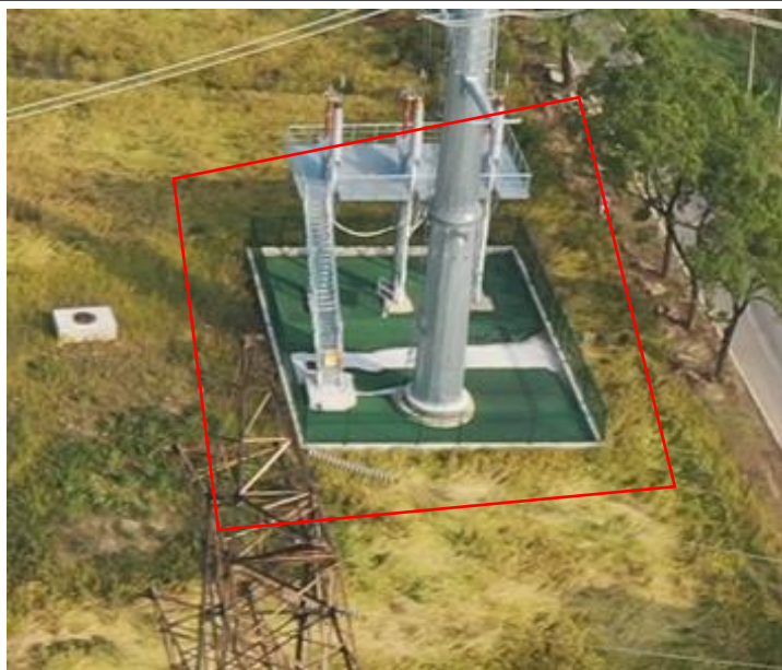
塔基区复耕现状（2024.11）
