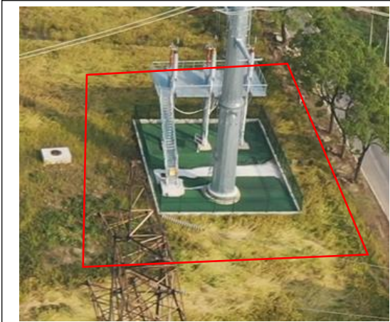
塔基区 T1 复耕 (2024.11)
