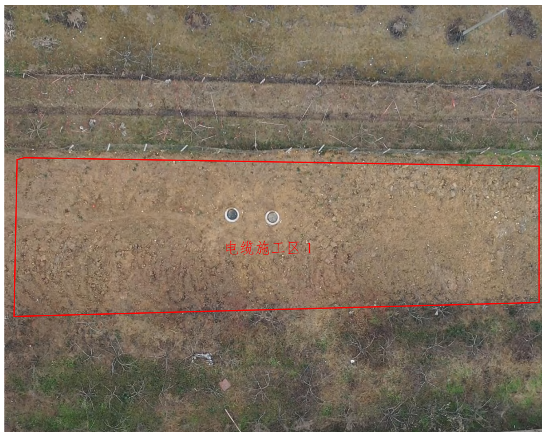
电缆施工区 1 施工后期 2024.12
