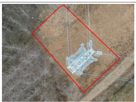
神山~沐东 26#塔基区 土地整治后恢复园地 (2024 年 12 月)
