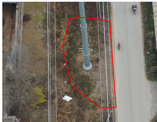
神山~沐东 30#塔基区 土地整治后撒播草籽 (2024 年 12 月)
