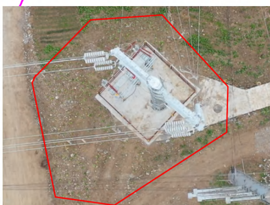
塔基区撒播草籽措施
