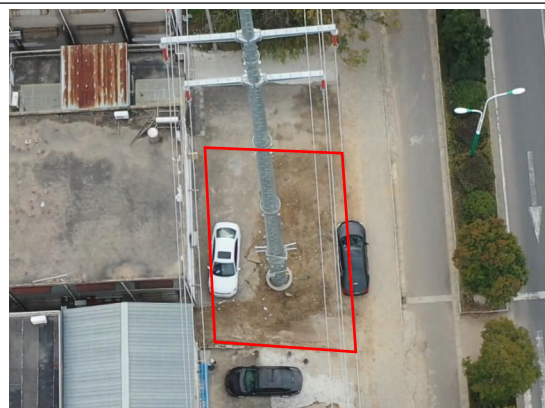
神山~沐东 10#塔基区 土地整治后撒播草籽 (2024 年 12 月)
