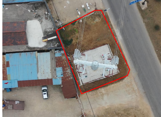
神山~沐东 22#塔基区 土地整治后撒播草籽 (2024 年 12 月)
