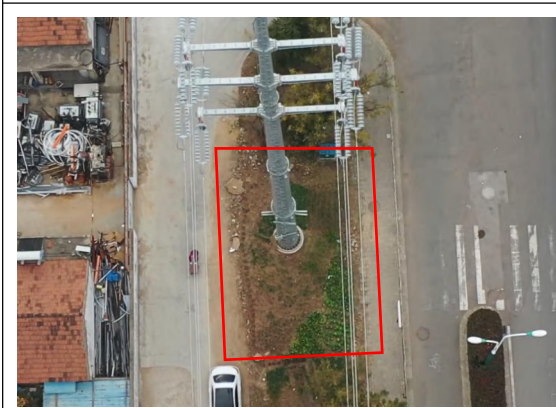
神山~沐东 9#塔基区 土地整治后撒播草籽 (2024 年 12 月)
