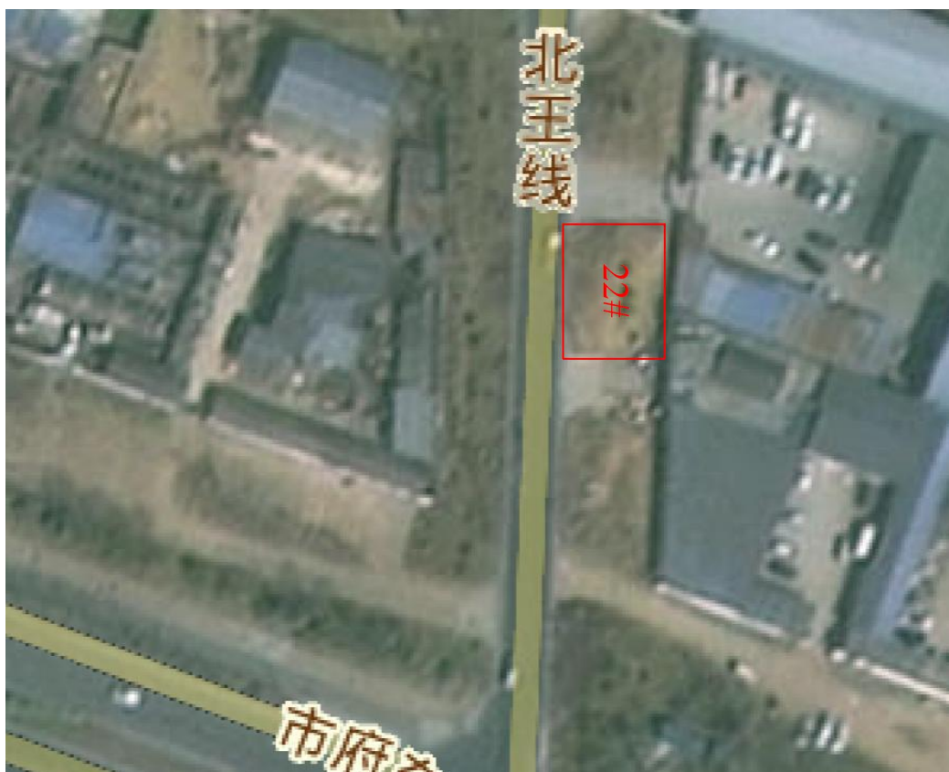
22#塔基区 施工前期 2023.3
