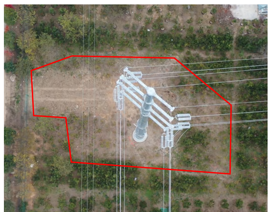
神山~沐东 28#塔基区 土地整治后恢复园地 (2024 年 12 月)
