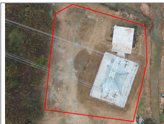
神山~沐东 23#塔基区 土地整治后恢复园地 (2024 年 12 月)
