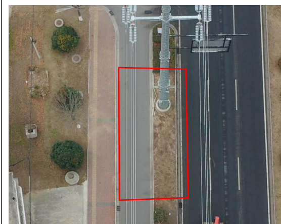
神山~沐东 15#塔基区 土地整治后撒播草籽 (2024 年 12 月)
