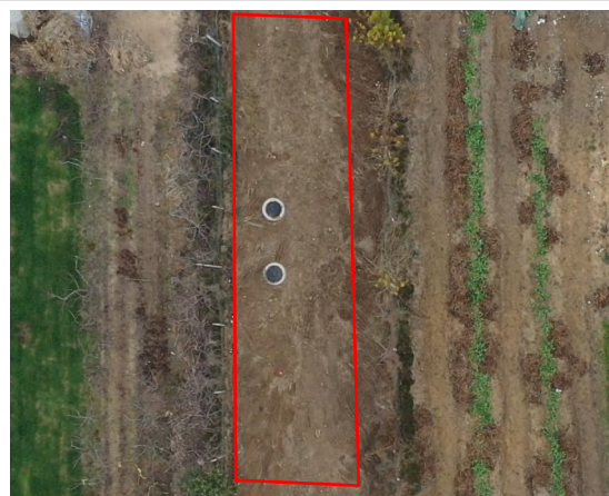
神山~沐东 电缆施工区 土地整治后恢复耕 地 (2024 年 12 月)
