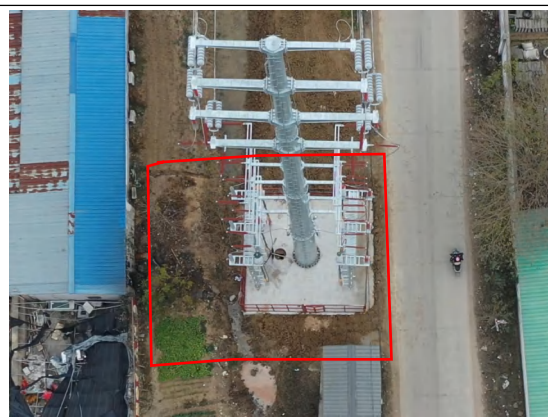
神山~沐东 31#塔基区 土地整治后撒播草籽 (2024 年 12 月)
