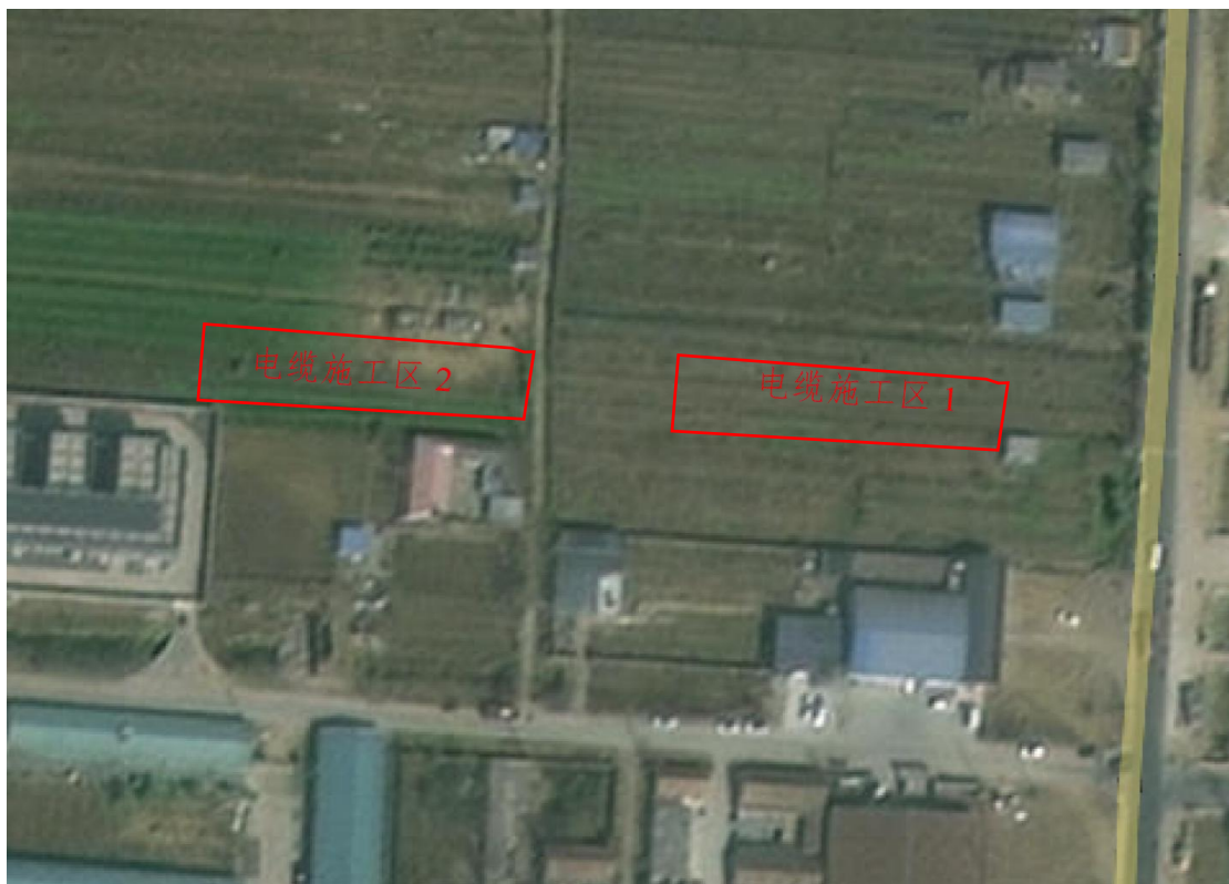
电缆施工区 施工前期 2023.7
