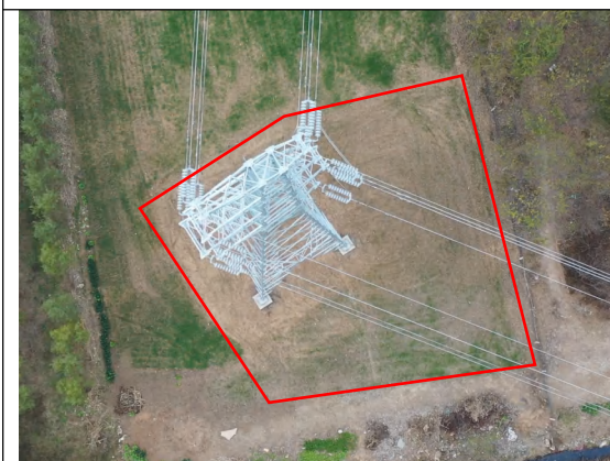
神山~沐东 25#塔基区 土地整治后恢复耕地 (2024 年 12 月)
