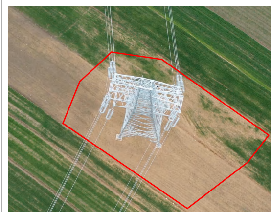
神山~沐东 27#塔基区 土地整治后恢复耕地 (2024 年 12 月)
