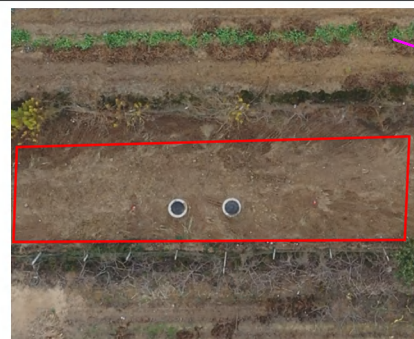
电缆施工区恢复耕地
