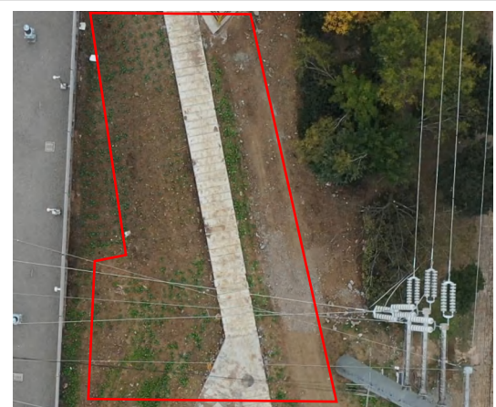
神山~沐东 电缆施工区 土地整治后撒播草 籽 (2024 年 12 月)
