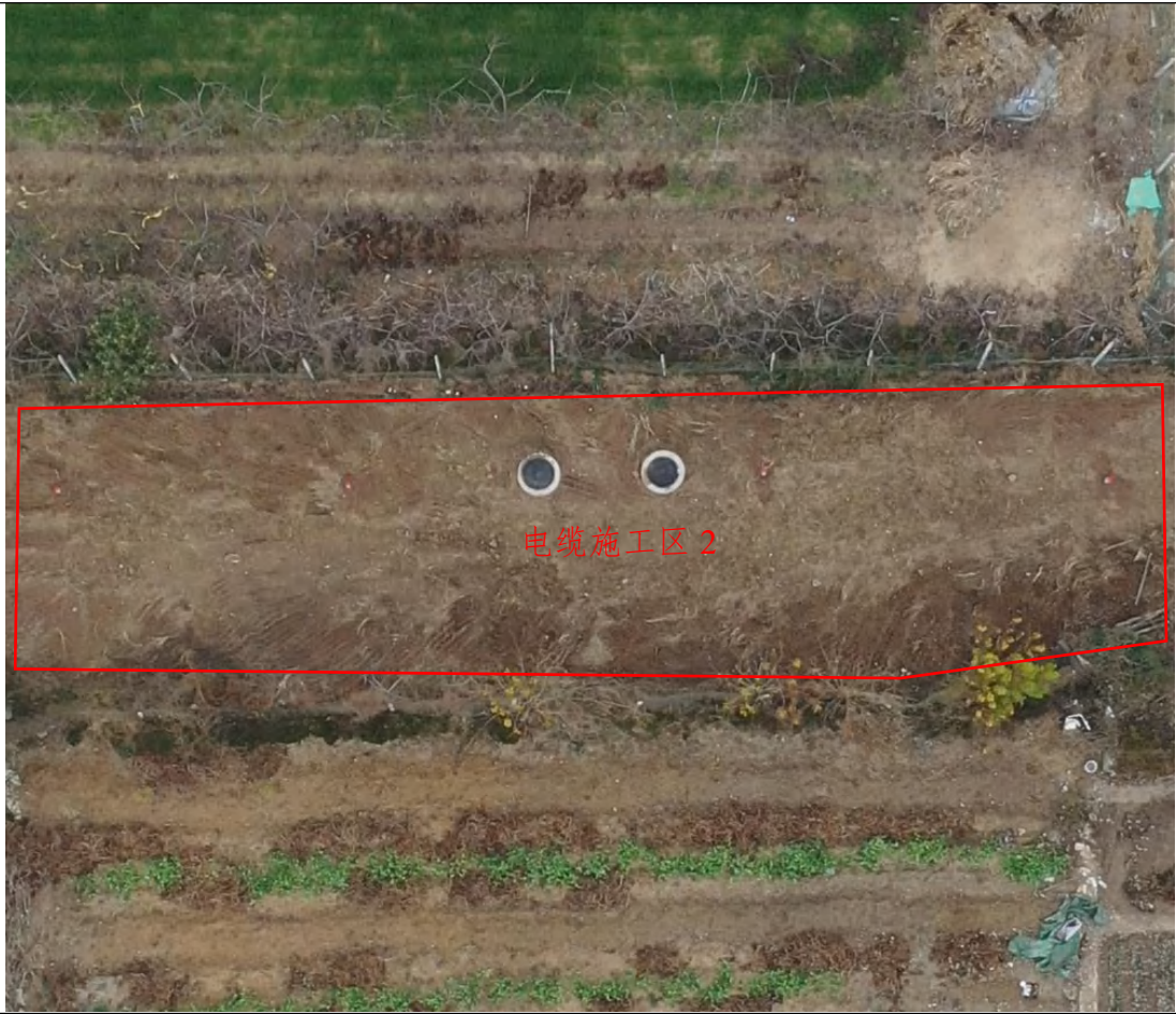
电缆施工区 2 施工后期 2024.12
