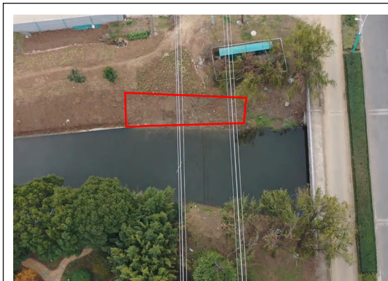
神山~沐东 牵张场及跨越场区撒播草籽 (2024 年 12 月)
