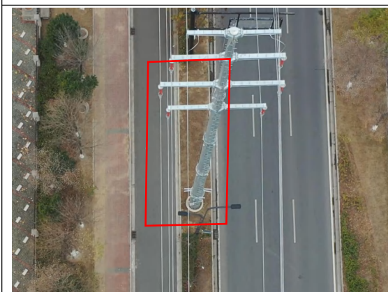
神山~沐东 19#塔基区 土地整治后撒播草籽 (2024 年 12 月)
