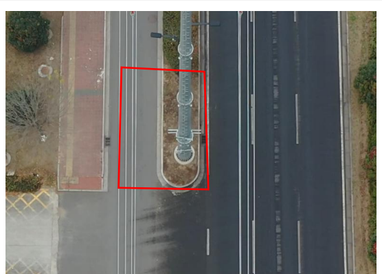
神山~沐东 14#塔基区 土地整治后撒播草籽 (2024 年 12 月)
