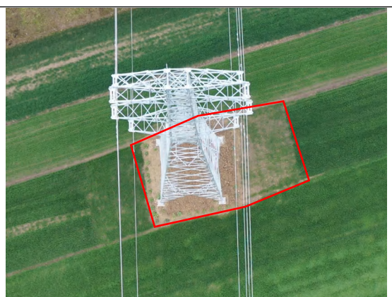
神山~沐东 24#塔基区 土地整治后恢复耕地 (2024 年 12 月)
