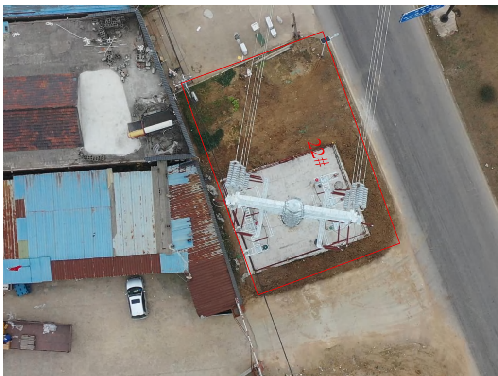
22#塔基区 施工后期 2024.12
