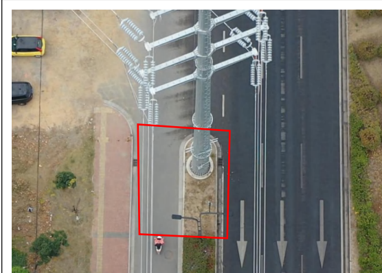
神山~沐东 13#塔基区 土地整治后撒播草籽 (2024 年 12 月)
