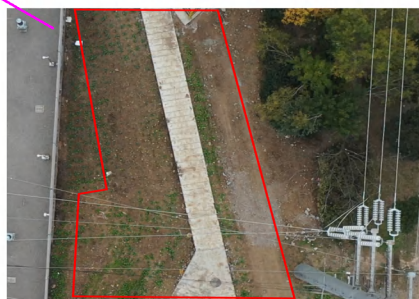
电缆施工区撒播草籽措施
