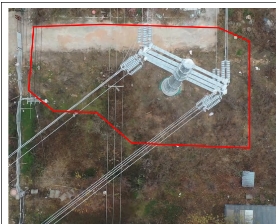
神山~沐东 29#塔基区 土地整治后撒播草籽 (2024 年 12 月)
