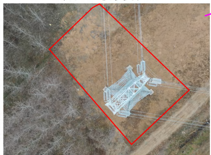
塔基区恢复园地
