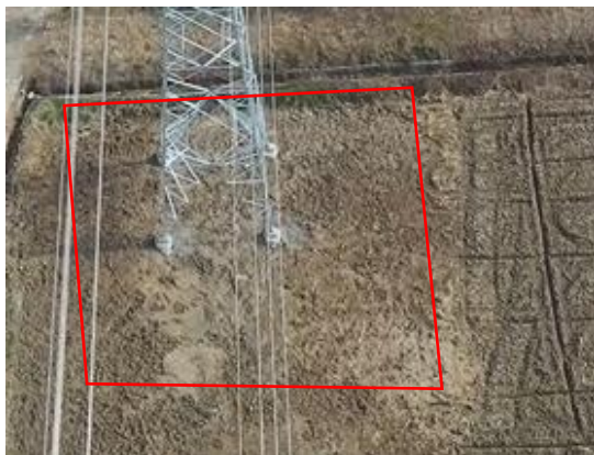
塔基区 T6 复耕 (2025.1)
