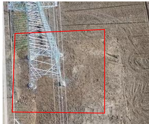
塔基区 T5 复耕 (2025.1)
