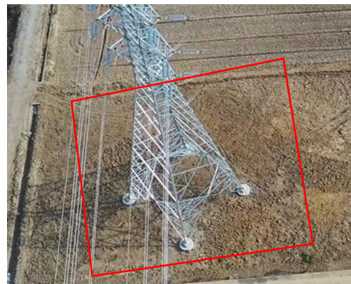
塔基区 T7 复耕 (2025.1)
