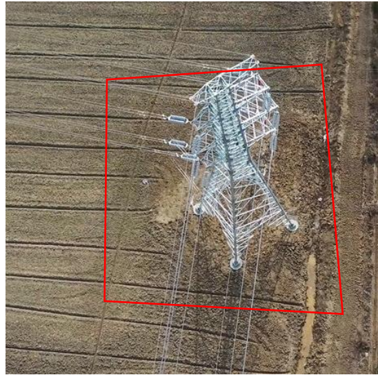
塔基区 T3 复耕 (2025.1)
