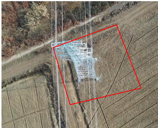
塔基区 T4 复耕 (2025.1)
