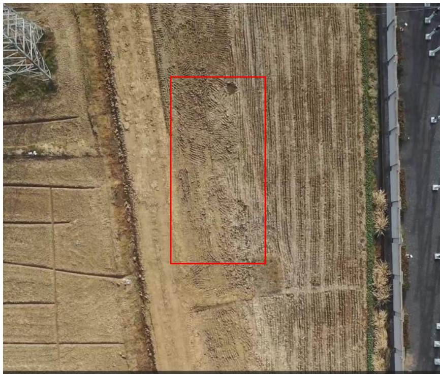
电缆施工区 复耕（2025.1）
