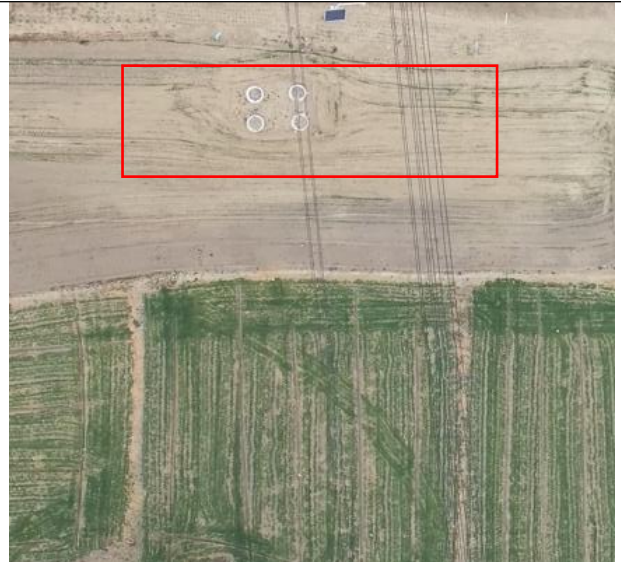
电缆施工区 施工后 (2025.2)
