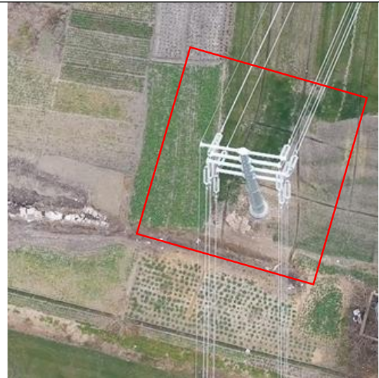
T2 塔基区 施工后 (2024.2)
