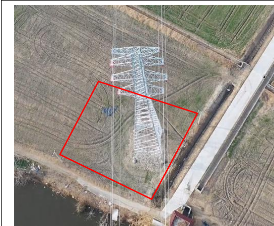
塔基区 T8 复耕 (2025.2)
