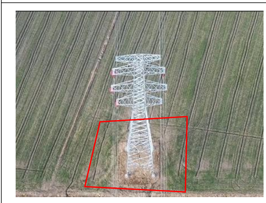
塔基区 T13 复耕 (2025.2)
