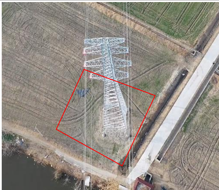
塔基区复耕现状 (2025.2)
