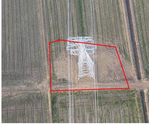
塔基区 T23 复耕 (2025.2)
