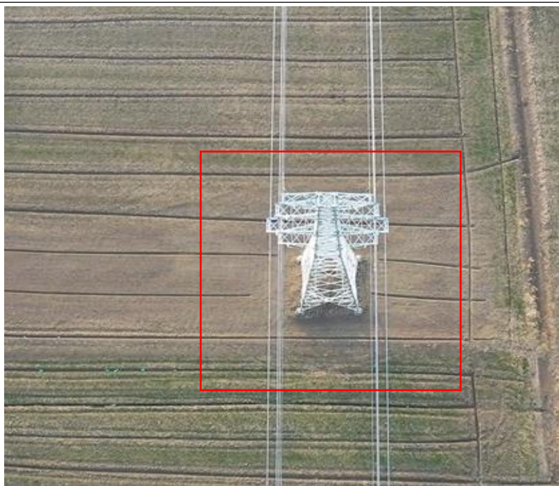
塔基区 T10 复耕现状 (2025.2)
