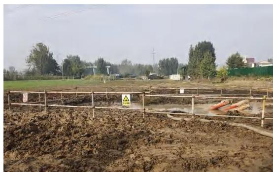
现场灌注桩施工开挖了泥浆沉淀池，但是场地裸露较多，缺少苫盖。
