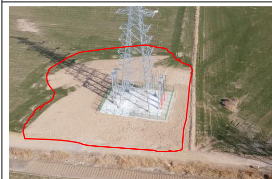
塔基区复耕 (2025 年 2 月)
