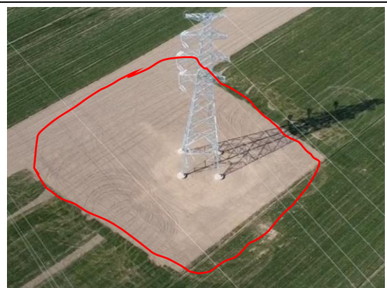
塔基区复耕 (2025 年 2 月)
