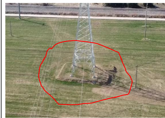
塔基区复耕 (2025 年 2 月)
