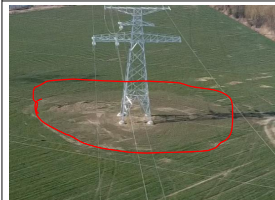
塔基区复耕 (2025 年 2 月)
