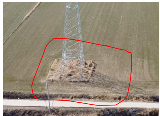
塔基区复耕 (2025 年 2 月)
