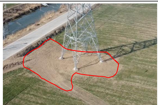
塔基区复耕 (2025 年 2 月)
