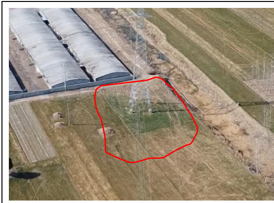
塔基区复耕 (2025 年 2 月)
