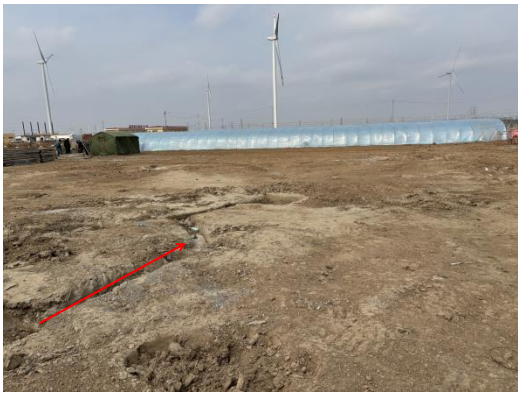
塔基及塔基施工区 临时排水沟
