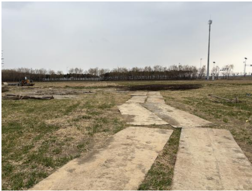
施工道路区 铺设钢板
