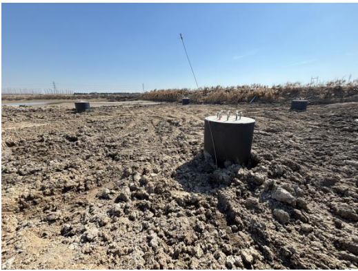
塔基及塔基施工区 基础施工
