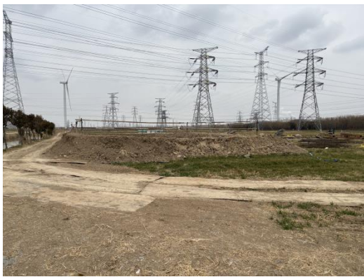
塔基及塔基施工区 泥浆沉淀池
