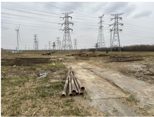
施工道路区 铺设钢板
