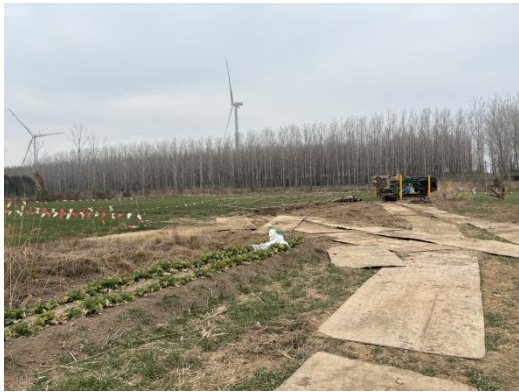
施工道路区 铺设钢板
