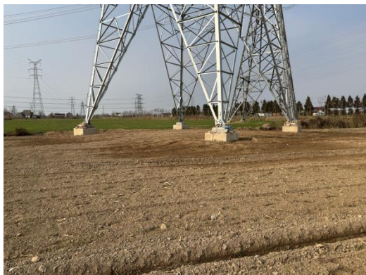
塔基及塔基施工区 复耕
