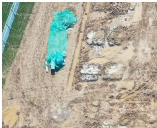
变电站区 临时排水沟、防尘网苫盖
