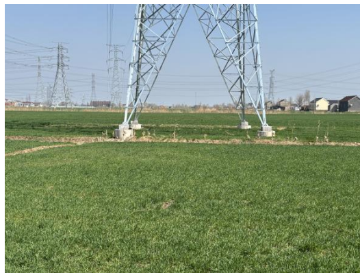
塔基及塔基施工区 复耕
