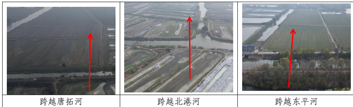
图 1.1-5 本工程架空线路跨越情况照片
