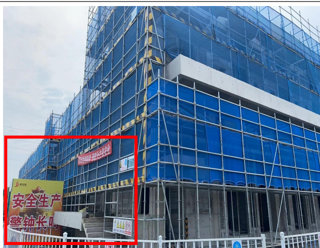
施工期脚手架以及警示标志
