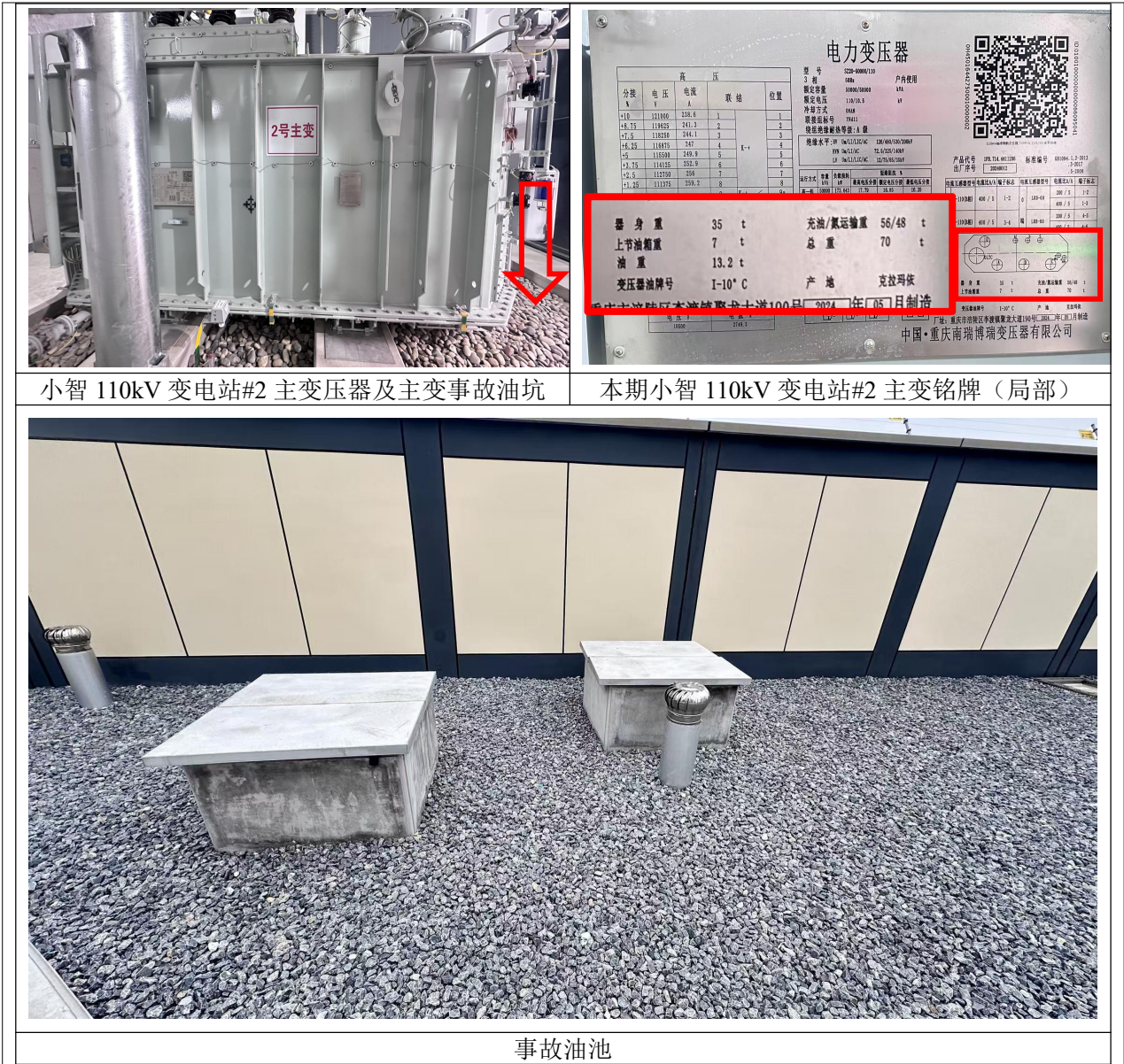
图 8-1 本次验收小智 110kV 变电站事故油坑、事故油池和主变铭牌照片
