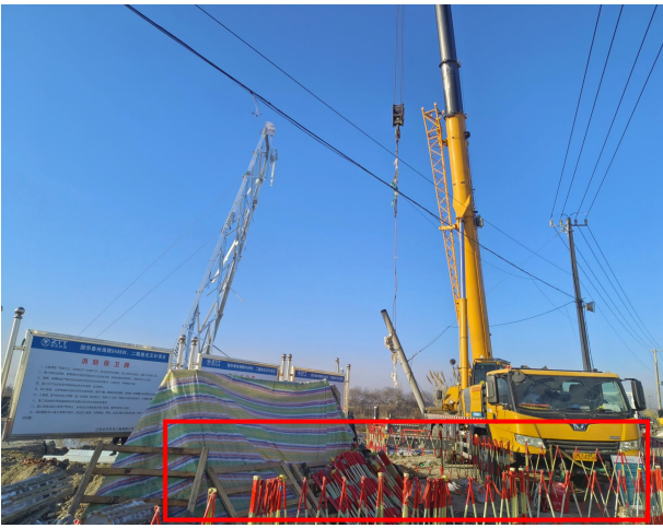
施工围栏以及吊车立塔
