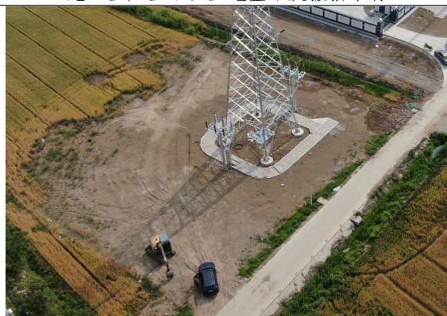
GT3塔土地整治（航拍）
