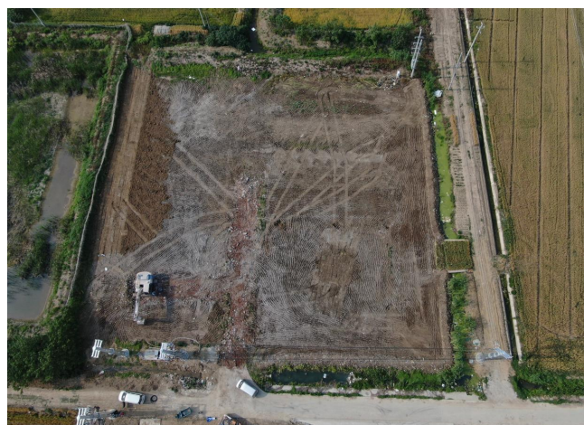
施工生产生活区土地整治及撒播草籽
