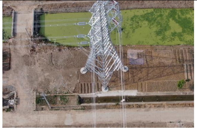
GT1塔土地整治（航拍）
