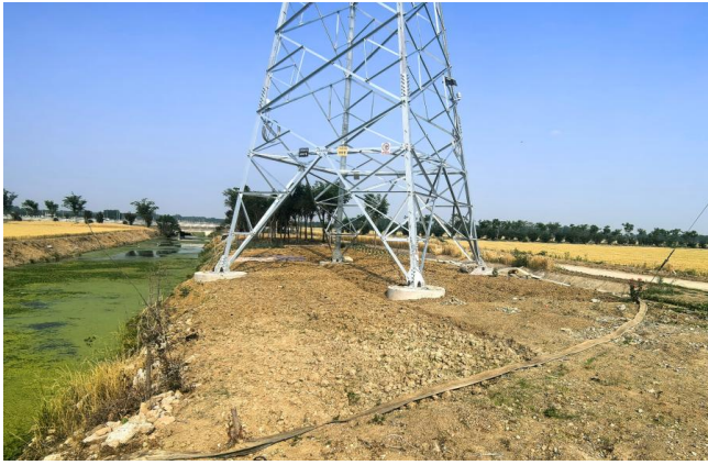
GT1塔土地整治（地面）
