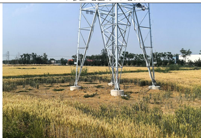
GT2塔土地整治（地面）
