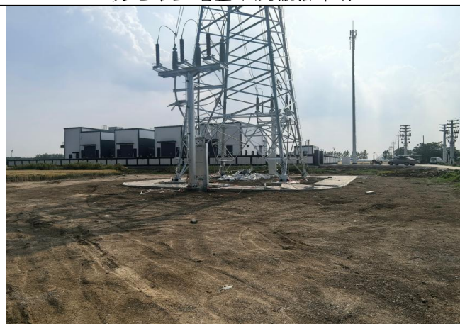
GT3塔土地整治（地面）
