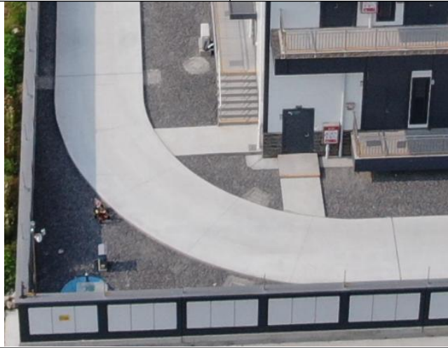
变电站区砾石压盖及雨水管网
