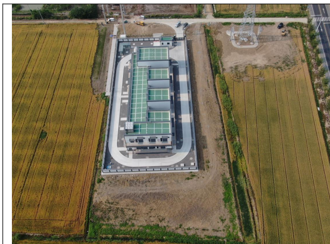
变电站土地整治及撒播草籽
