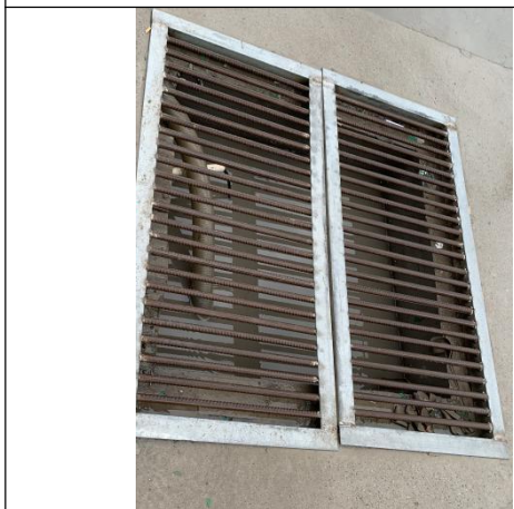
变电站区沉沙池（2023.12）
