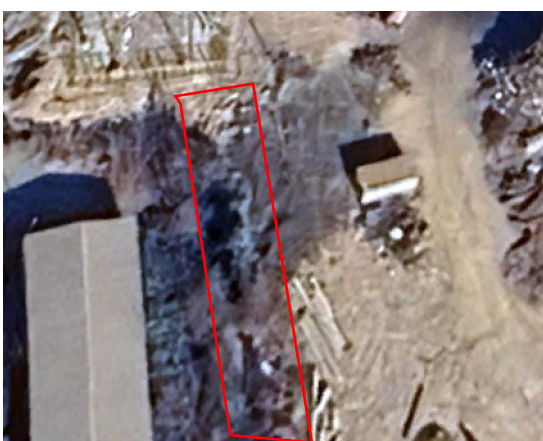
电缆施工区撒播草籽（2023.11）
