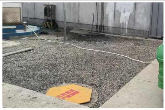
变电区砾石压盖（2025.5）
