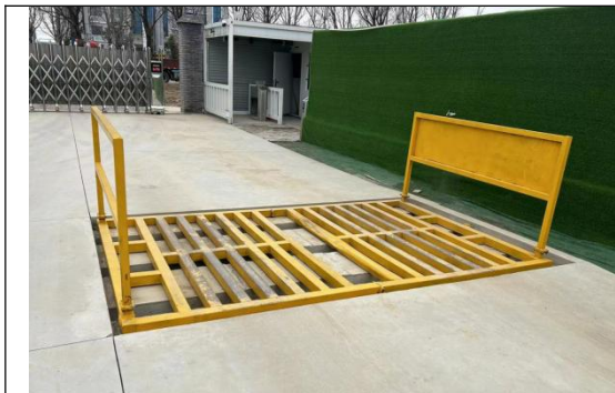
变电站区洗车平台（2023.10）
