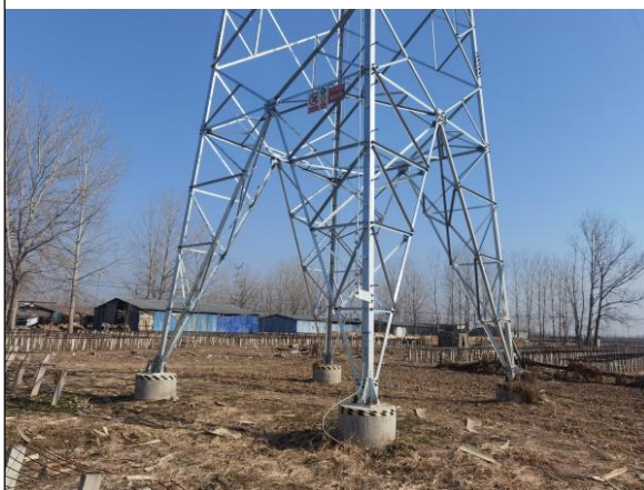
塔基区撒播草籽（2025.3）
