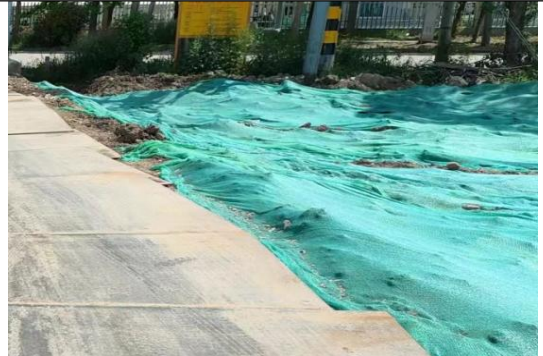
施工临时道路土地整治（2024.10）
