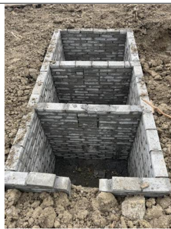
施工生产生活区沉沙池（2023.12）
