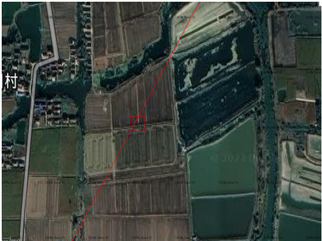
施工前（塔基区 T11、2024 年 1 月）
