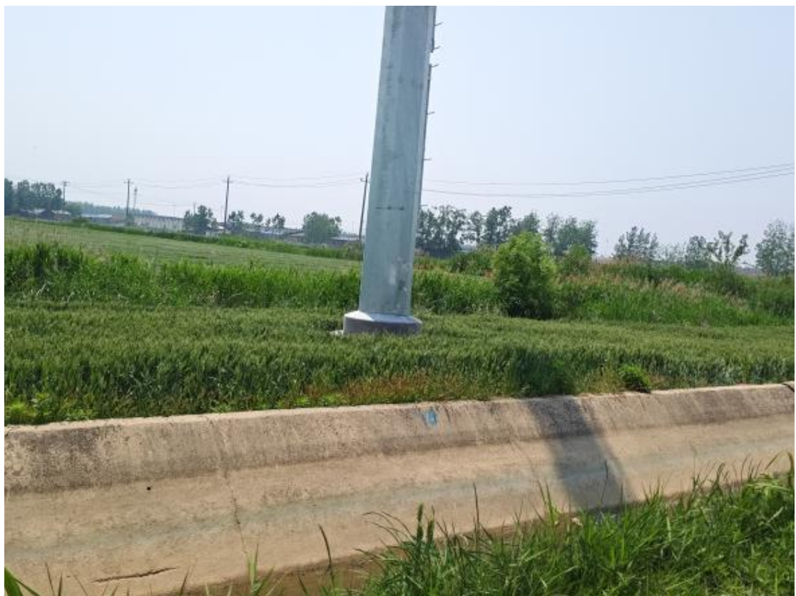
施工后（塔基区 T11、2025 年 6 月）
