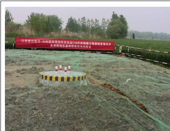
塔基区密目网苫盖（2024.9）
