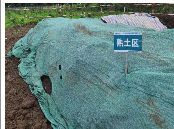
塔基区密目网苫盖（2024.4）
