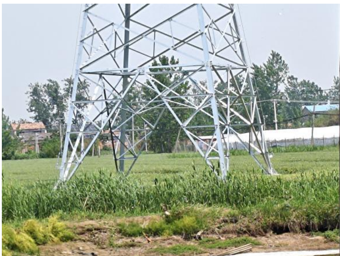
施工后（塔基区 T25、2025 年 6 月）
