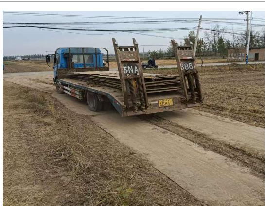
施工道路区铺设钢板（2024.5）
