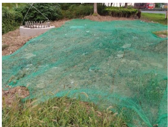
塔基区密目网苫盖（2024.9）
