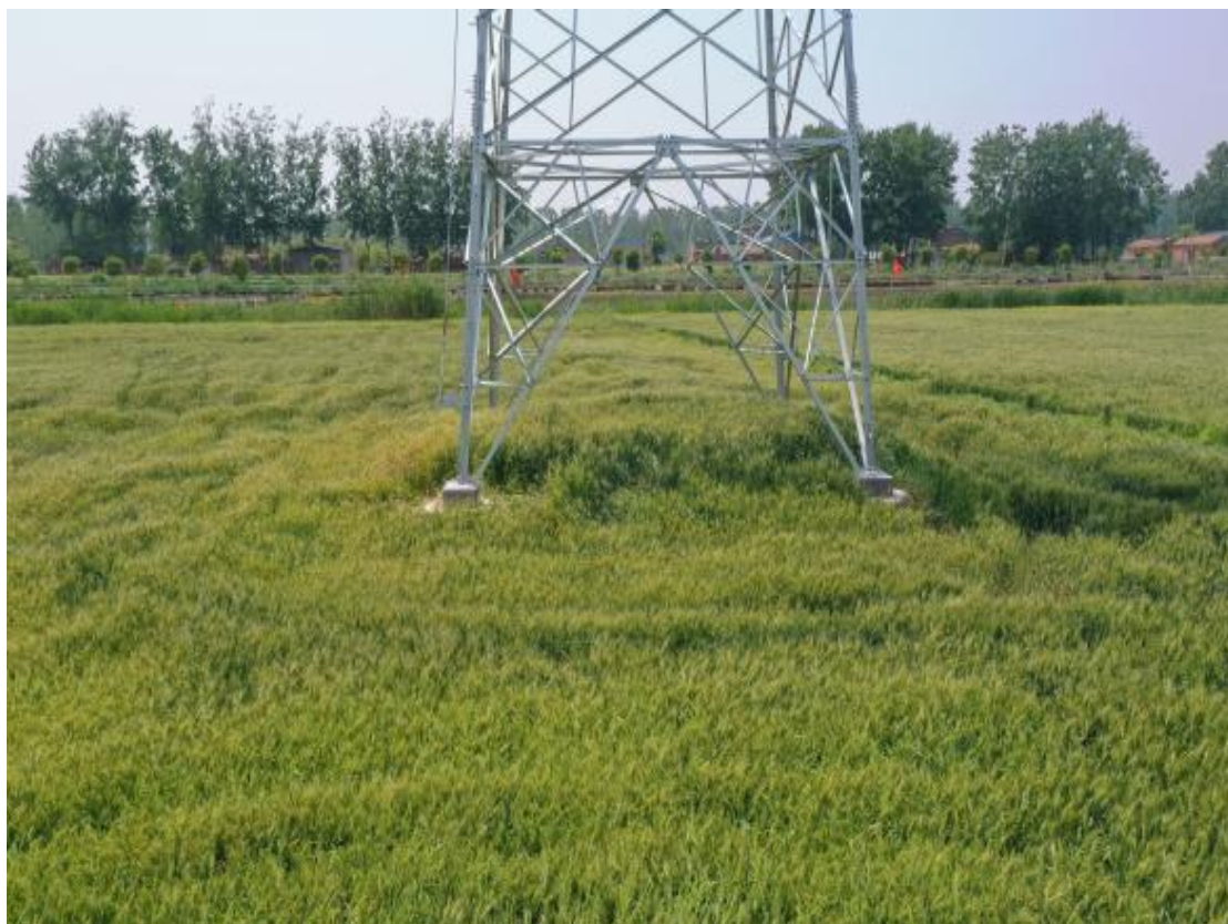
施工后（塔基区 T27、2025 年 6 月）
