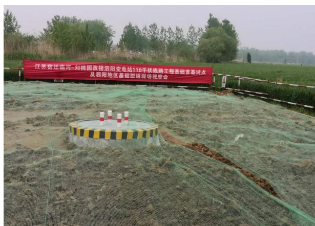
施工中（塔基区 T25、2024 年 6 月）
