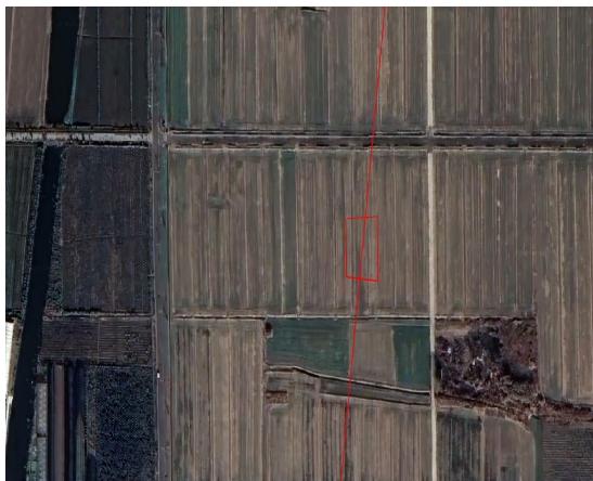
施工前（塔基区 T27、2024 年 1 月）
