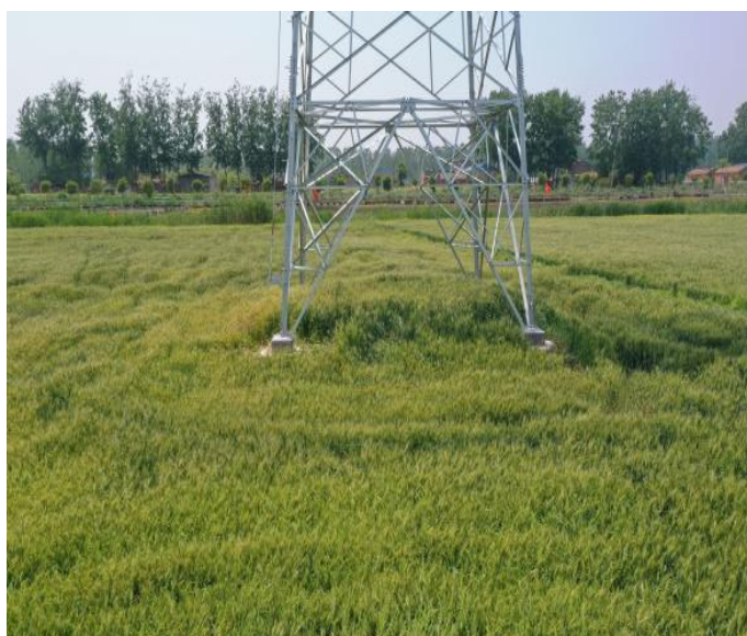
施工后（塔基区 T27、2025 年 6 月）
