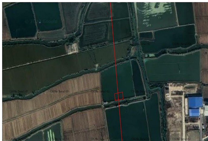
施工前（塔基区 T25、2024 年 1 月）
