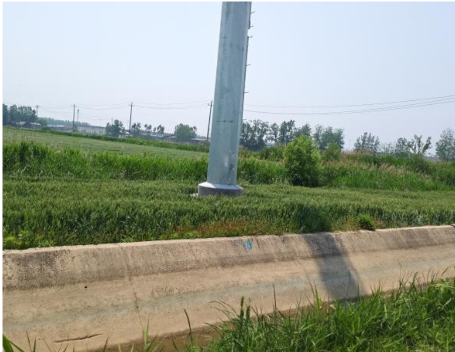
施工后（塔基区 T11、2025 年 6 月）
