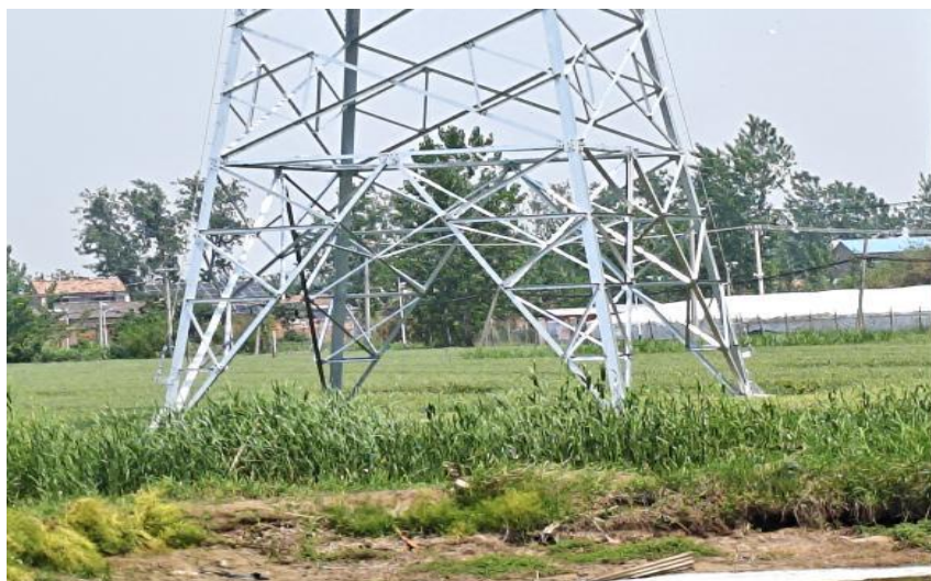
施工后（塔基区 T25、2025 年 6 月）
