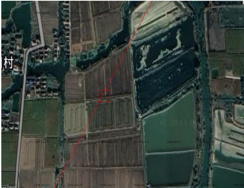
施工前（塔基区 T11、2024 年 1 月）
