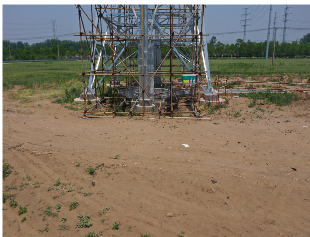
施工中（塔基区 T27、2025 年 3 月）
