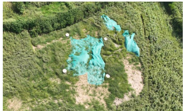
塔基及塔基施工区临时苫盖 (2023.05)
