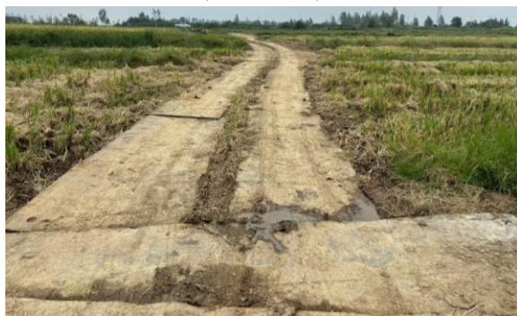
临时施工道路区铺设钢板 (2023.05)
