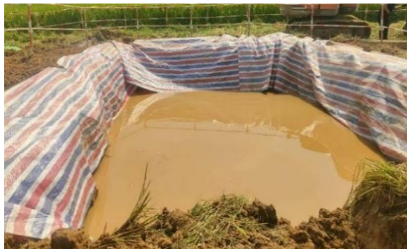
塔基及塔基施工区泥浆沉淀池 (2023.05)
