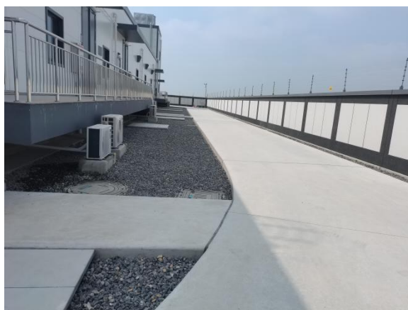
站内道路硬化
