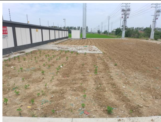
新建 110kV 电缆
