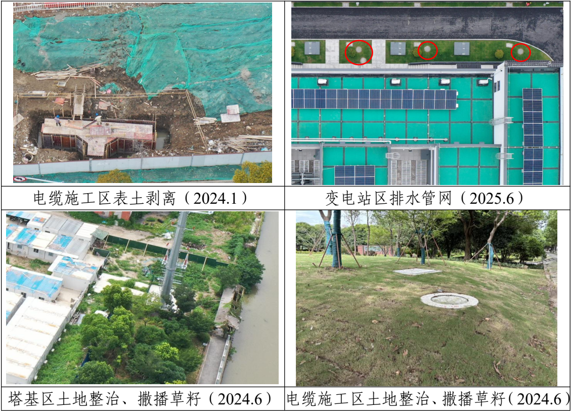
图 4-1 水土保持工程措施实施情况
