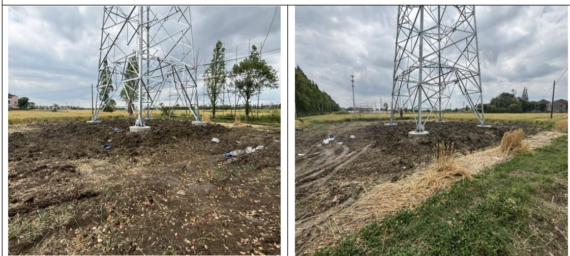
塔基区 土地整治（2025.5）
