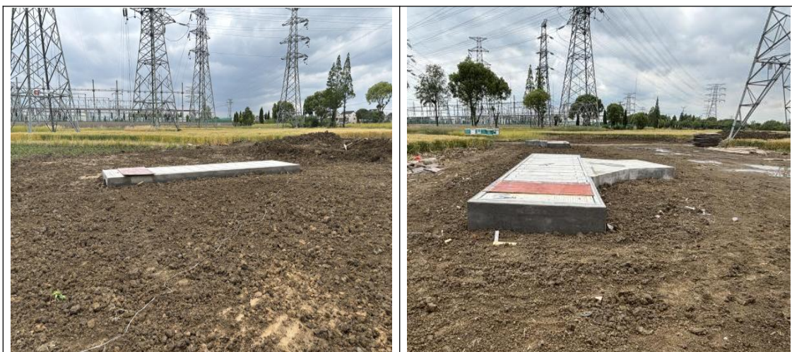
电缆施工区 土地整治（2025.5）
