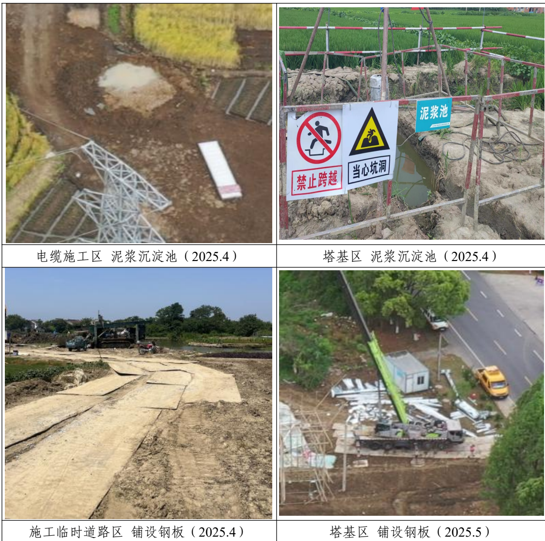
图 4-2 水土保持临时措施实施情况
