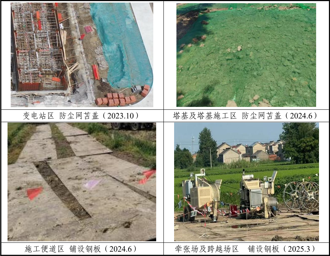
图 3.5-3 临时措施实施照片
