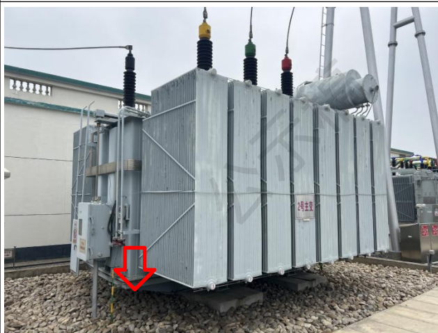
振丰 110kV 变电站#2 主变压器事故油坑
