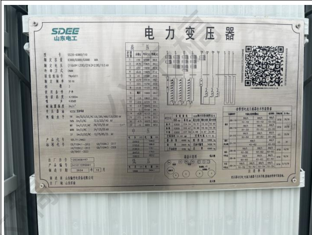
振丰 110kV 变电站#1 主变铭牌
