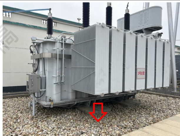
振丰 110kV 变电站#3 主变压器事故油坑
