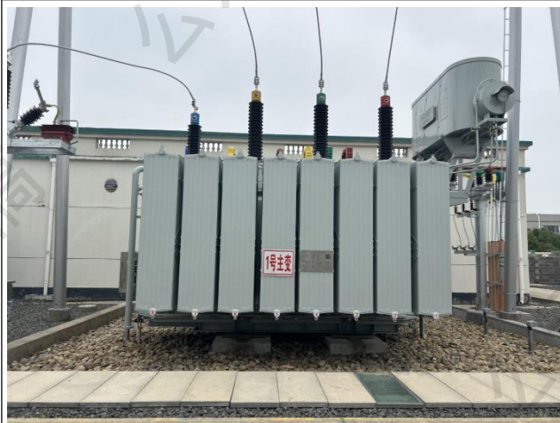
本期更换振丰 110kV 变电站#1 主变压器
