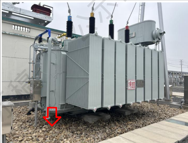
振丰 110kV 变电站#1 主变压器事故油坑
