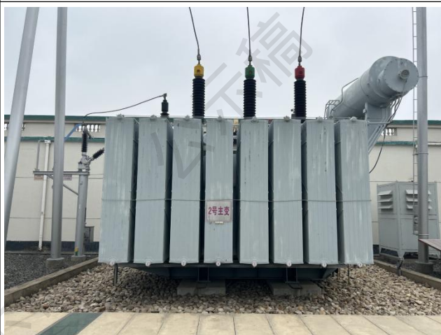
振丰 110kV 变电站#2 主变压器
