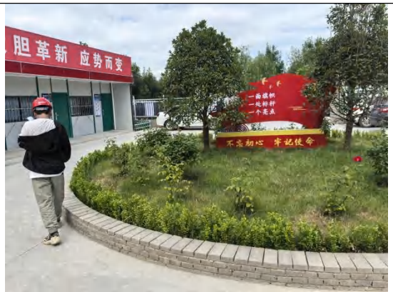
施工生产生活区临时绿化（2024.06）
