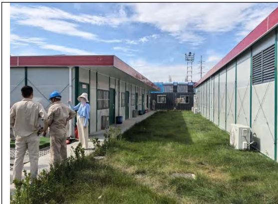
施工生产生活区临时绿化（2024.06）
