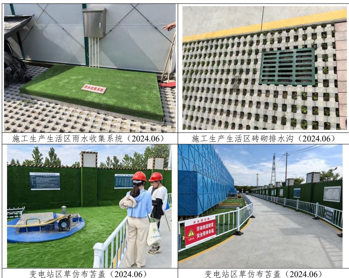
图 4-3 水土保持临时措施实施情况
