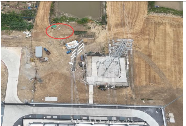
变电站南侧第 1 基杆塔塔基恢复情况（110kV 线路）
