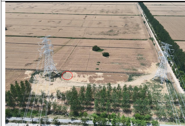
220kV 庄瑶线开环处拆除塔基恢复情况（220kV 线路）
