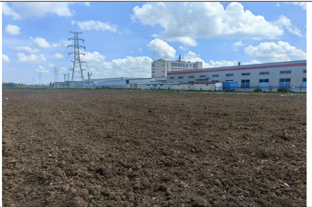
施工项目部拆除后的土地恢复（变电站东侧）
