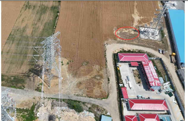
变电站北侧第 1 基杆塔塔基恢复情况（110kV 线路）
