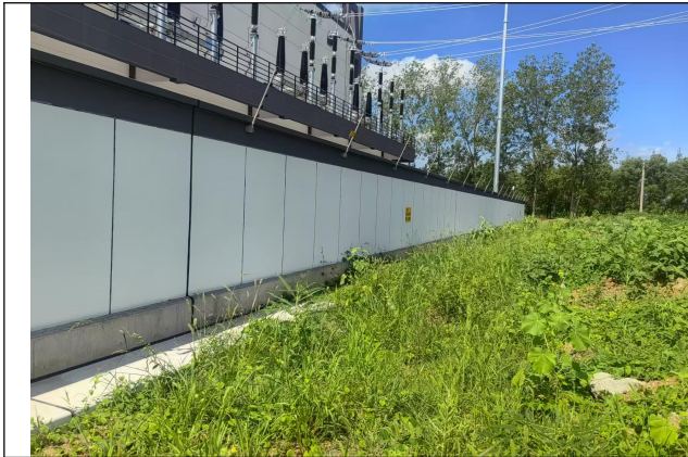
站外植被恢复（变电站北侧）
