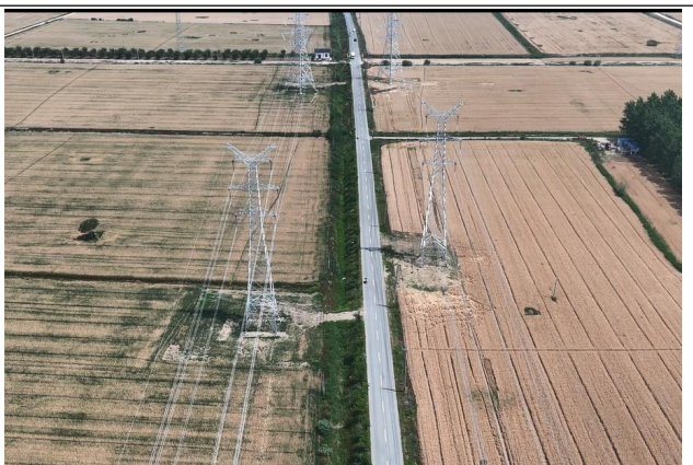
塔基周围植被恢复（220kV 瑶利 49U9 线#80/广利 49U0 线#125、220kV 利庄 46M3/46M4 线#004）
