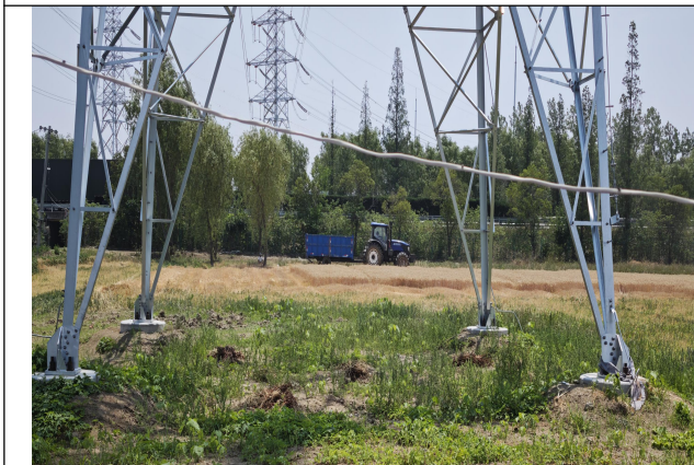
塔基周围植被恢复（220kV 瑶利 49U9 线#82/广利 49U0 线#127）
