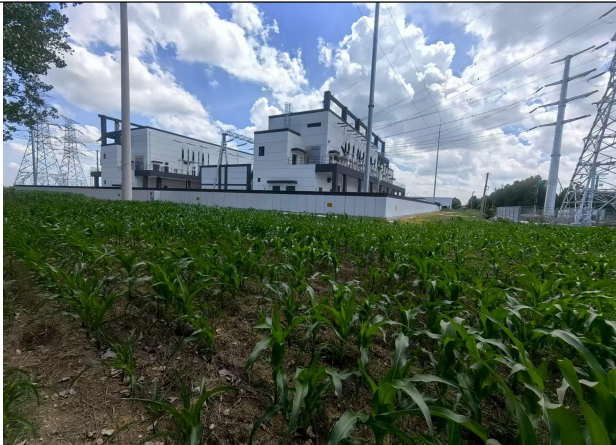
站外复耕（变电站西侧）
