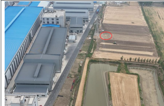
变电站南侧第 2 基杆塔塔基恢复情况（110kV 线路）
