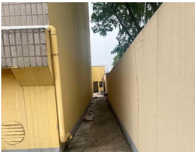
站内硬化道路
