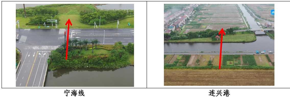
图 1.1-8 工程主要跨越道路、河流现状
