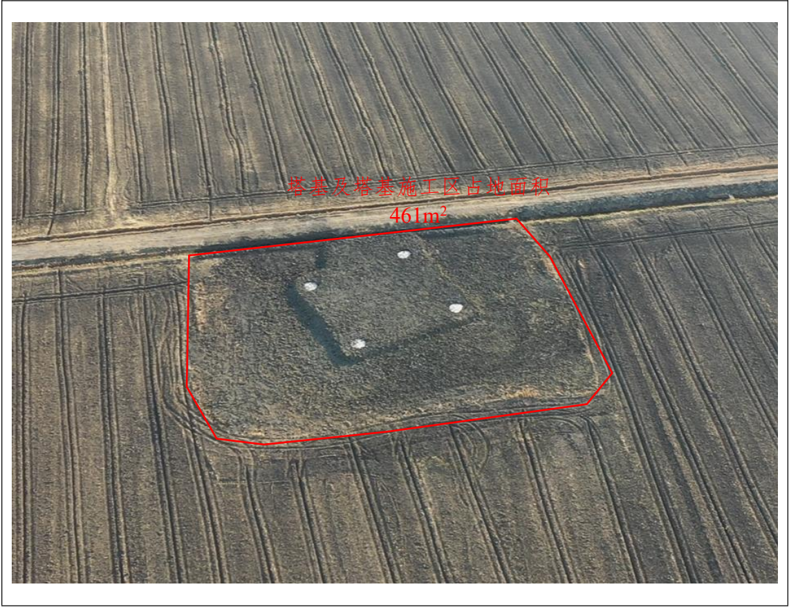
图 3-1 塔基区施工范围遥感影像
