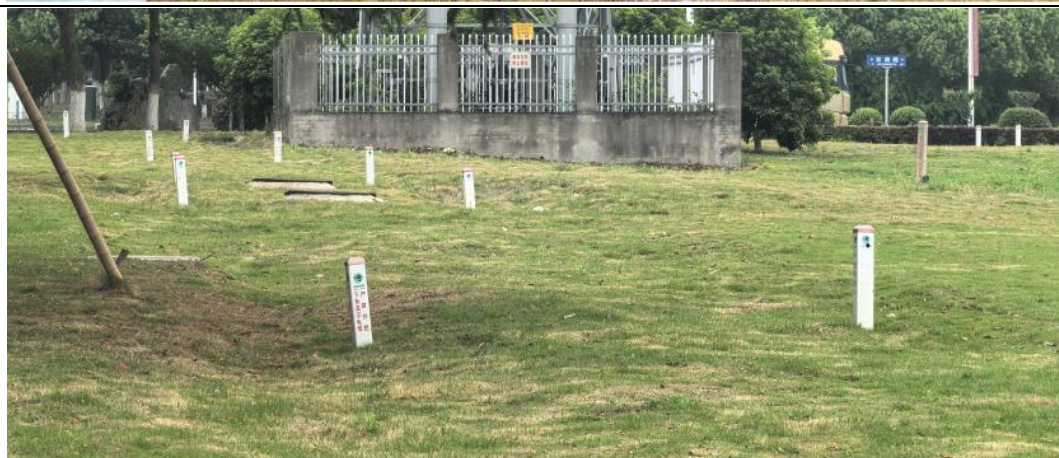
图6-3 本项目电缆线路沿线生态恢复示例及警示标志照片
