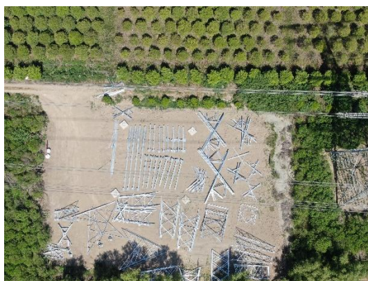
T1 塔基正射影像图（2025.04.25）
