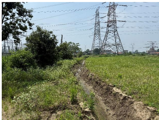
临时排水沟（塔基区）
