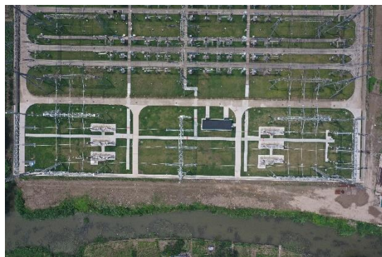
铺植草皮（变电站扩建区）
