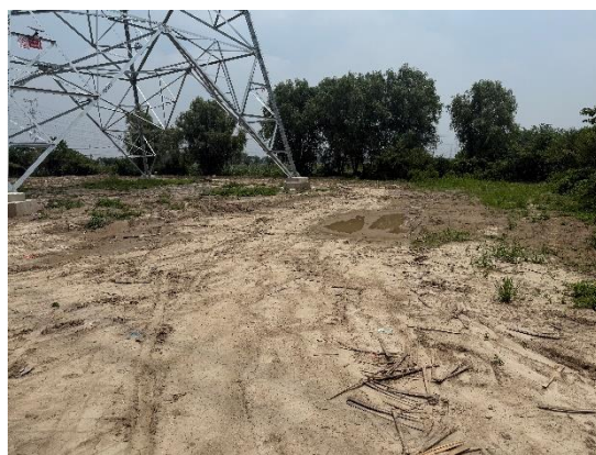
土地整治（塔基区）
