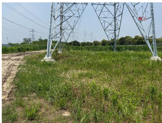
撒播草籽（塔基区）
