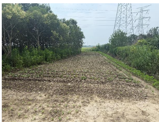
土地整治（临时道路）
