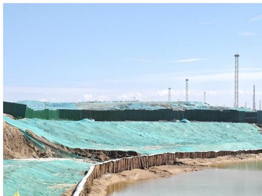
塔基及塔基施工区 防尘网苫盖
