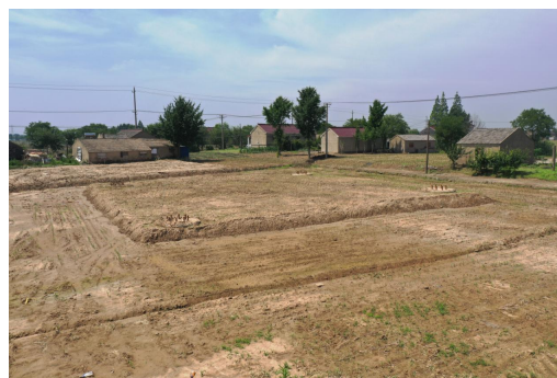
塔基及塔基施工区 临时排水沟
