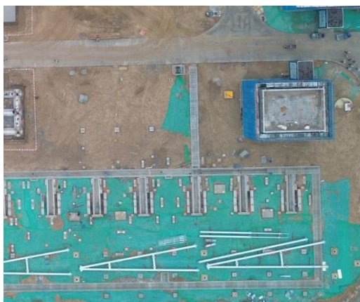
变电站区 临时苫盖
