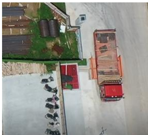
施工生产生活区洗车平台
