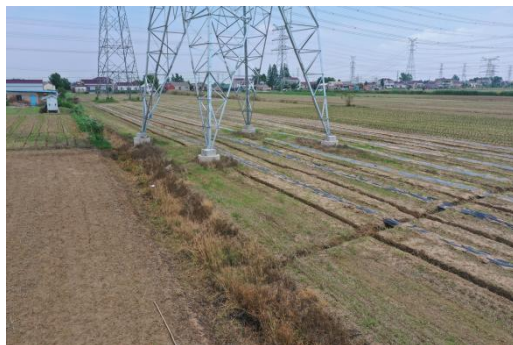
塔基及塔基施工区 复耕
