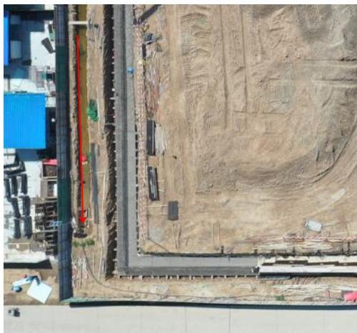
变电站区 临时排水沟
