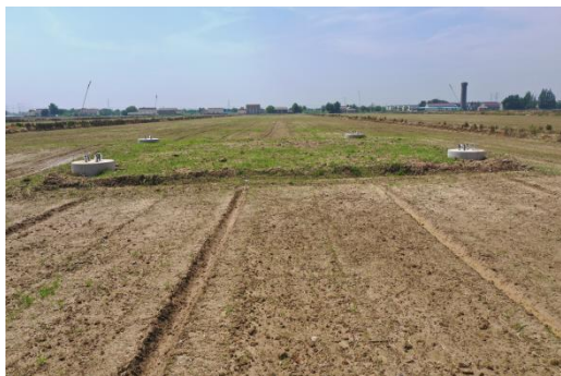
塔基及塔基施工区 临时排水沟
