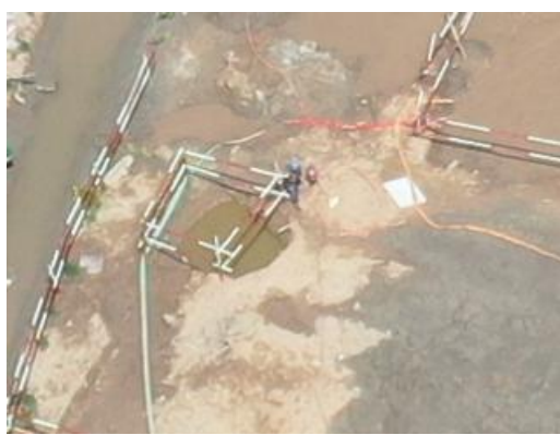
塔基及塔基施工区 临时沉沙池
