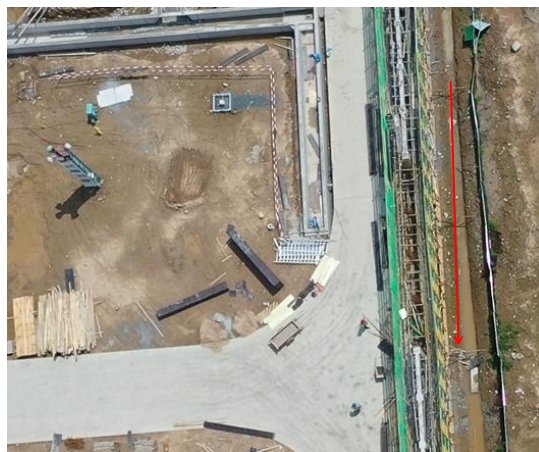
变电站区 临时排水沟
